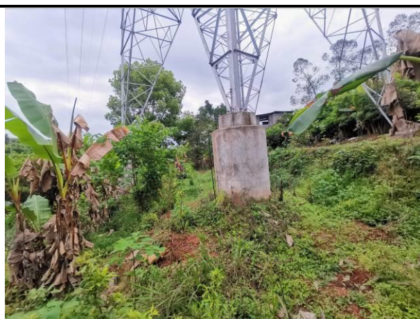
N6 塔基及施工临时占地恢复情况
