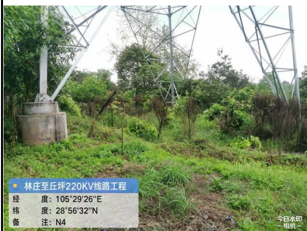
N4 塔基及施工临时占地恢复情况
