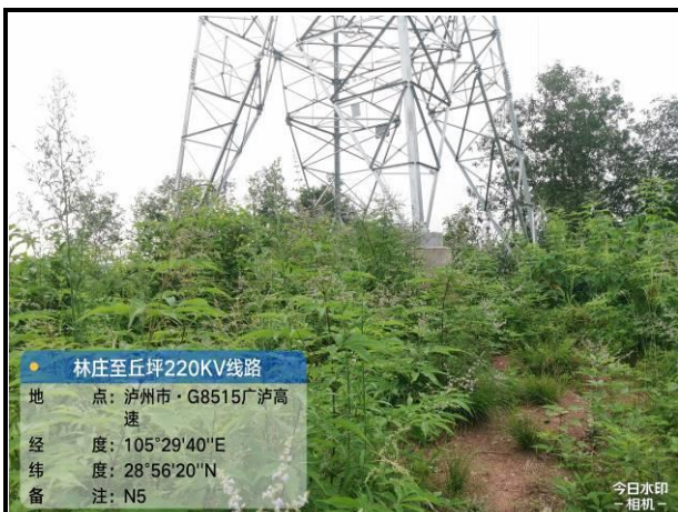
N5 塔基及施工临时占地恢复情况
