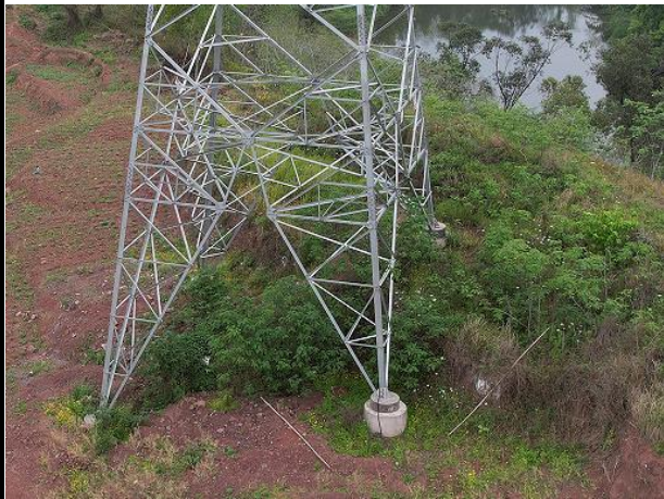
N10 塔基及施工临时占地恢复情况
