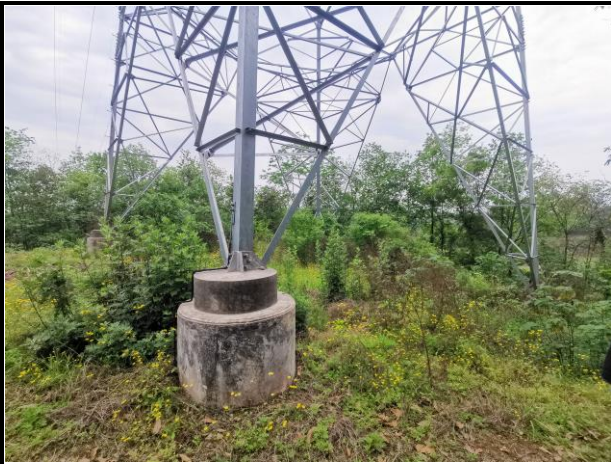
N9 塔基占地恢复情况
