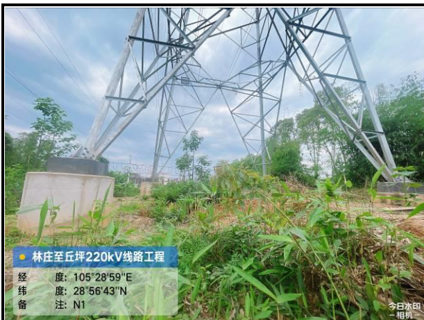
N1 塔基及施工临时占地恢复情况
