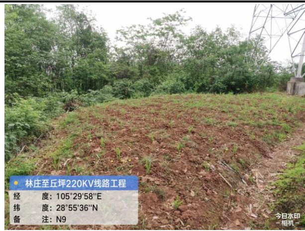
N9 塔基施工临时占地恢复情况
