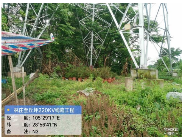
N3 塔基及施工临时占地恢复情况
