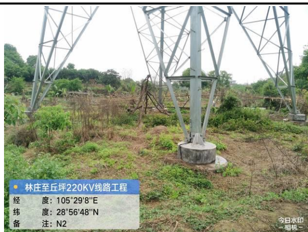
N2 塔基及施工临时占地恢复情况
