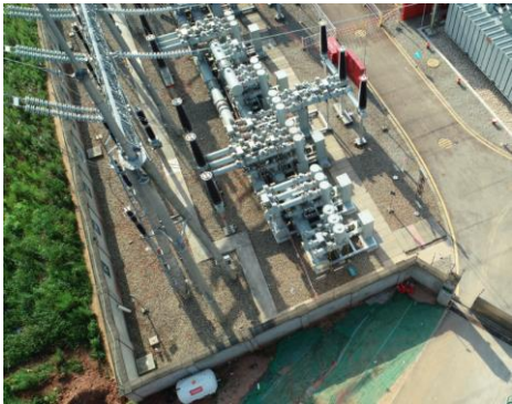
清河 220kV 变电站间隔扩建工程区碎石铺设
