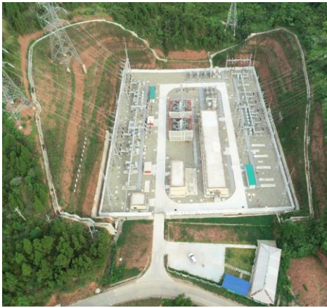
变电站内硬化铺设碎石，站外设置截排水沟、植草护坡，施工场地已土地整治撒播草籽
