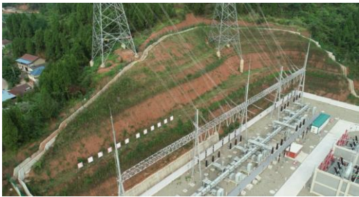
变电站新建工程区截水沟和边坡整治
