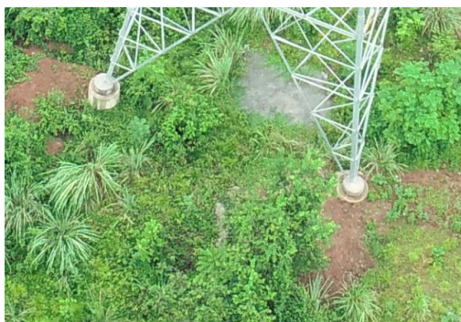
杨胡～灵泉 220kV 线路工程 3#、44#塔基建渣未清理，需加强绿化措施
