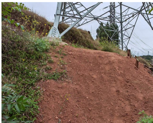
清河～灵泉 220kV 线路工程 2#、3#塔基建渣未清理、未采取绿化措施
