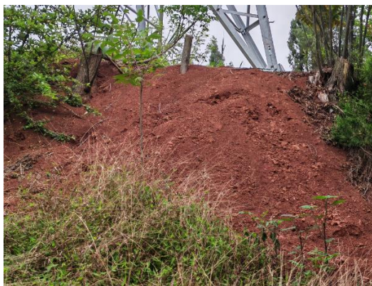
清河～灵泉 220kV 线路工程 2#、3#塔基建渣未清理、未采取绿化措施
