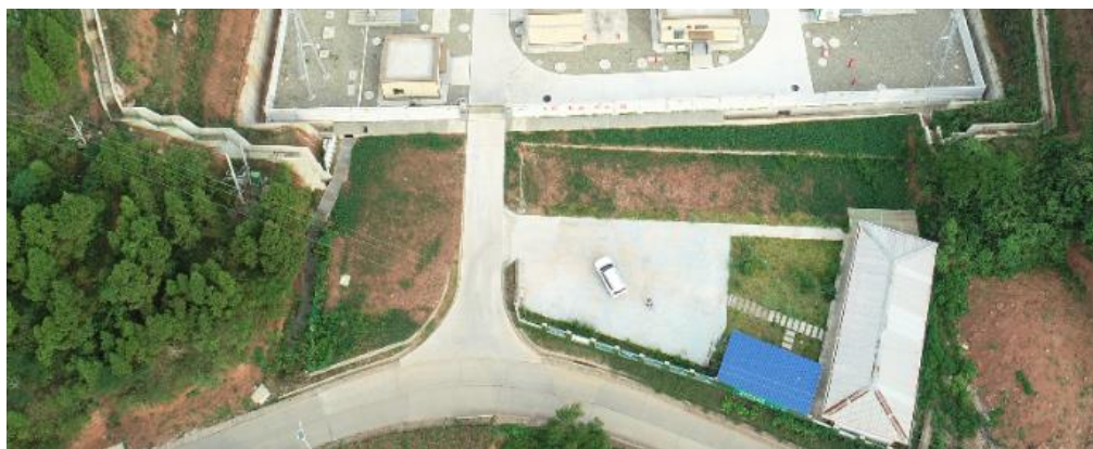
灵泉变电站外临时设施场地仍有硬化场地和板房未拆除
