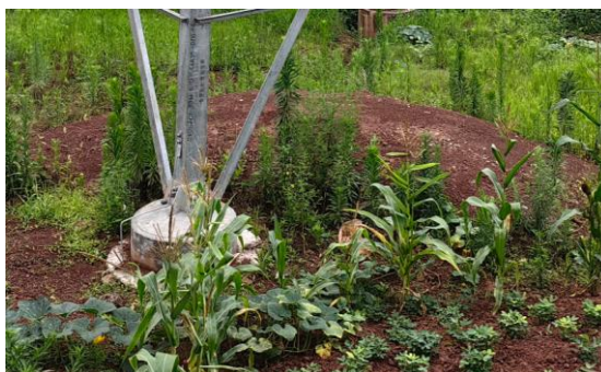
杨胡～灵泉 220kV 线路工程 3#、44#塔基建渣未清理，需加强绿化措施
