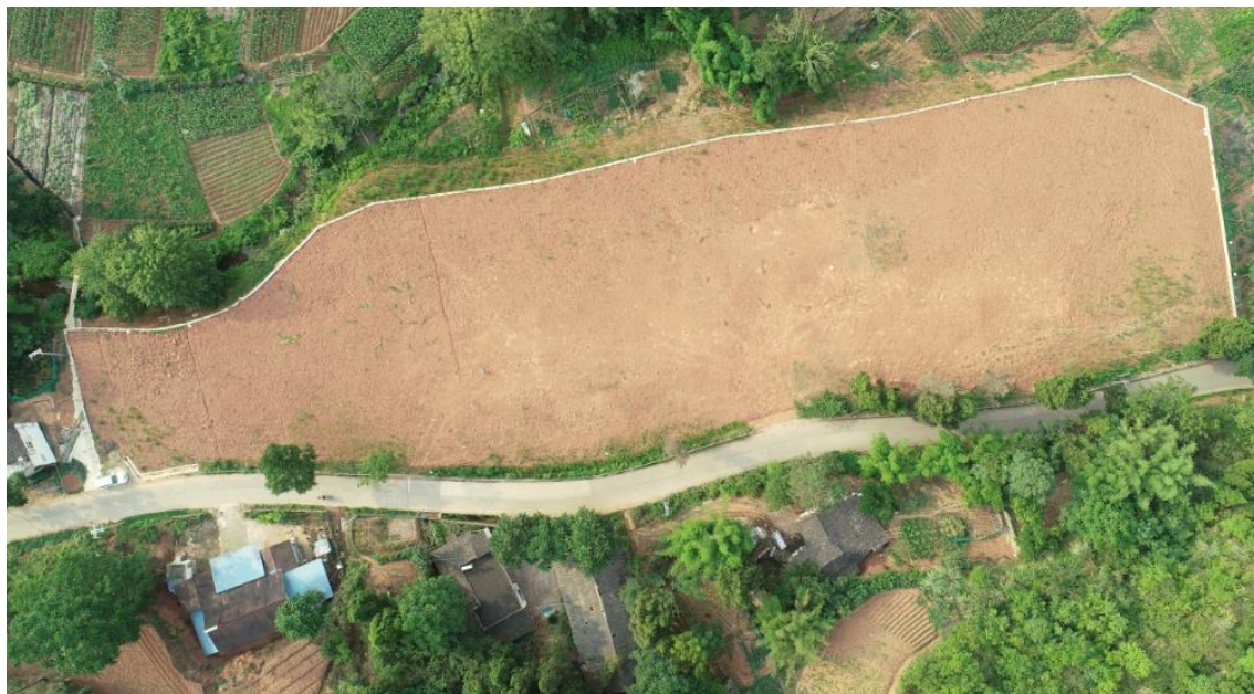
弃渣场挡墙、土地整治后复耕
