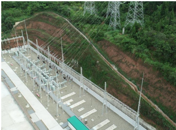
变电站新建工程区场内铺设碎石及边坡防护
