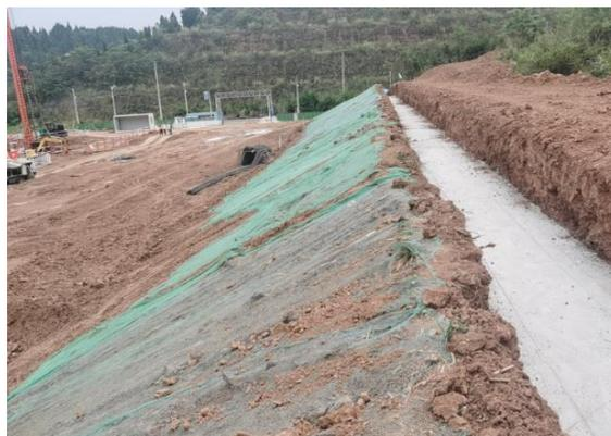
变电站站区截水沟（正在施工）和边坡遮盖
