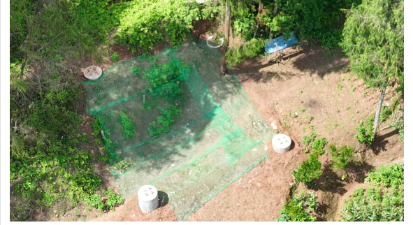
阆北-马鞍牵引站（N116）-基础浇筑后平整、密目网遮盖
