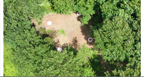
仪陇-马鞍牵引站（G106）-基础浇筑后平整
