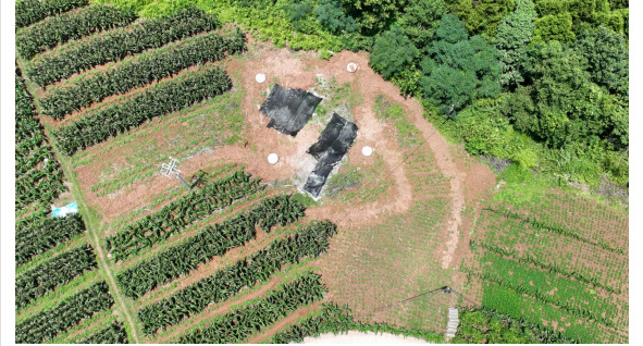
阆北-马鞍牵引站（N26）-基础浇筑后平整、密目网遮盖
