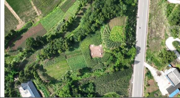
仪陇-马鞍牵引站（G104）-基础浇筑后平整
