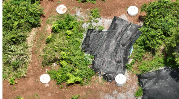
阆北-马鞍牵引站（N61）-基础浇筑后平整、密目网遮盖
