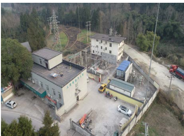
响滩 35kV 变电站
