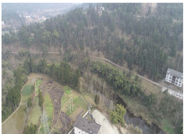
响滩 35kV 变电站出线方向
