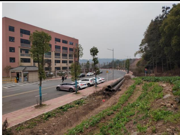
马鞍 110kV 变电站侧利旧电缆通道沿线情况
