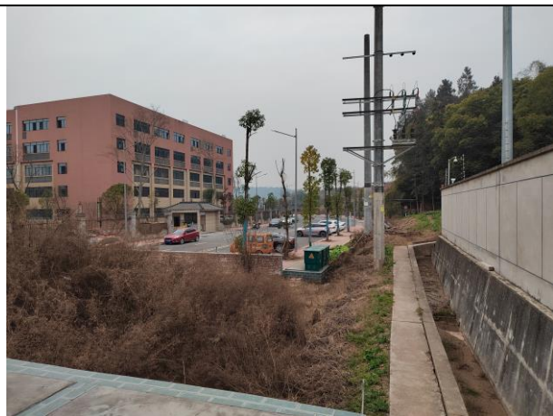
马鞍 110kV 变电站周围情况
