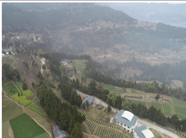
镇庙 35kV 变电站出线方向
