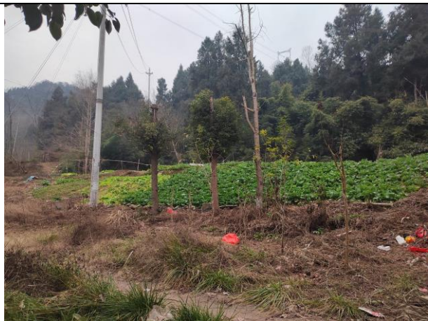
马鞍 110kV 变电站侧新建电缆沿线情况
