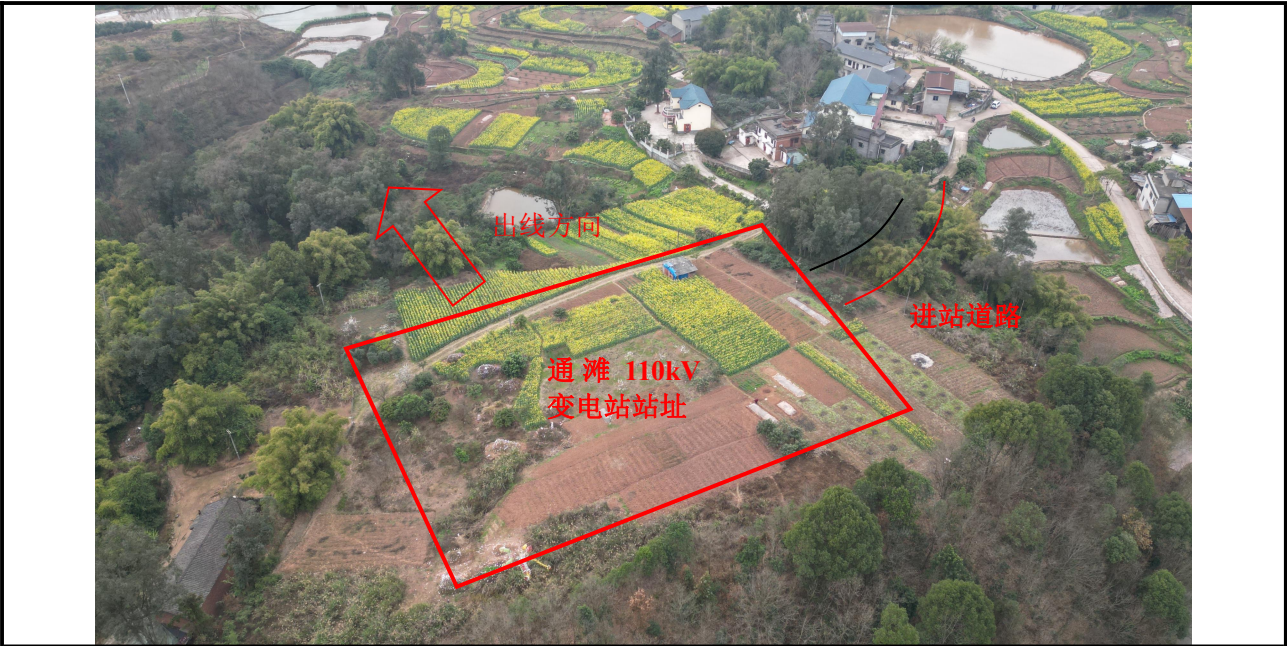
通滩 110kV 变电站站址现状
