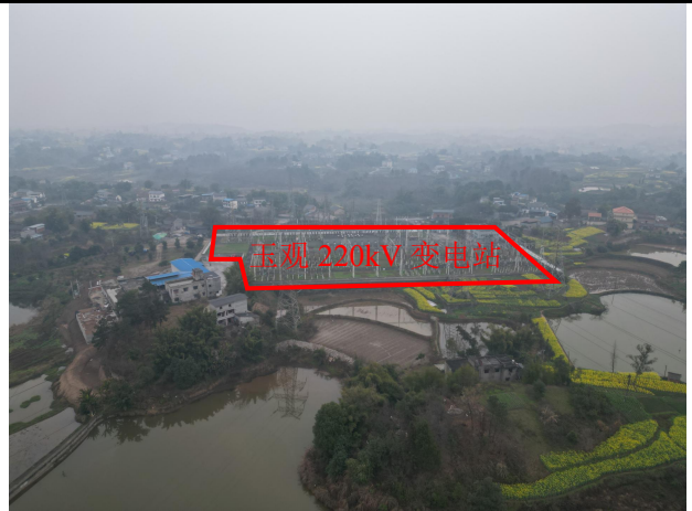
玉观变电站出线沿线情况
