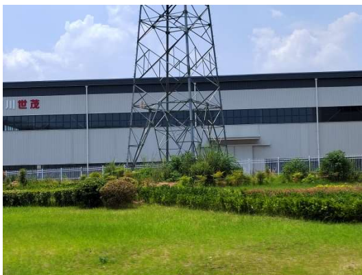
N14 号塔现状
