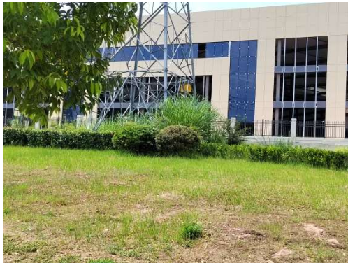
N12 号塔现状
