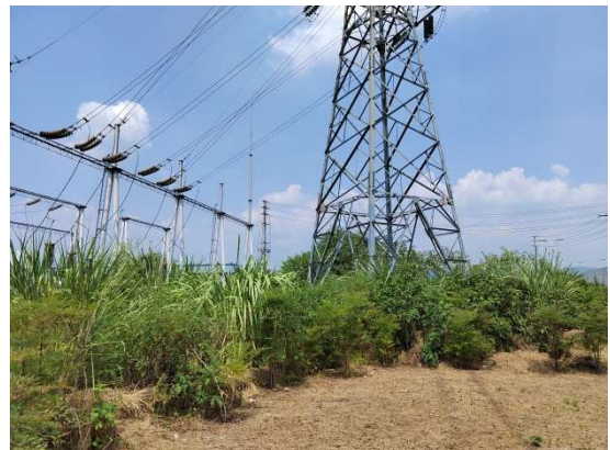
N15 号塔现状
