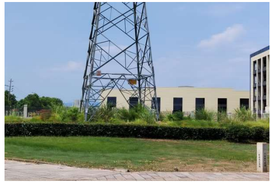
N11 号塔现状
