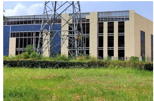
N13 号塔现状
