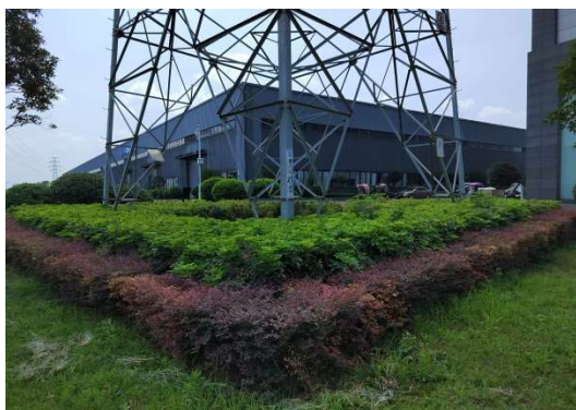
N1 号塔现状
