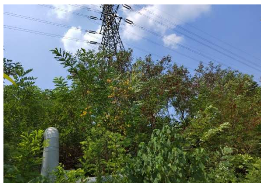
N3 号塔现状
