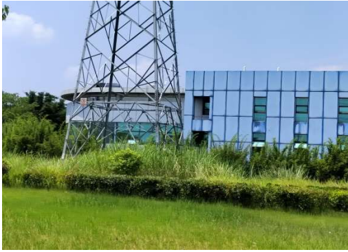
N10 号塔现状
