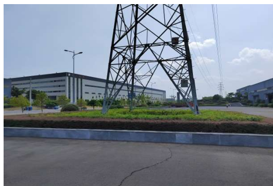
N2 号塔现状
