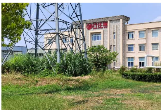
N7 号塔现状
