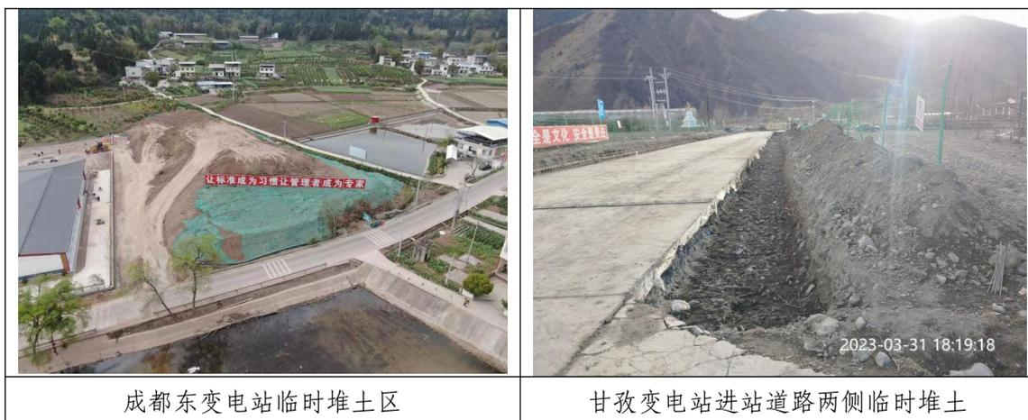
(2) 施工生产生活区边坡裸露无苫盖措施，建议及时进行植物措施覆盖，减少边坡裸露，短期可利用密目网苫盖进行防护。现场问题情况如下图所示：
