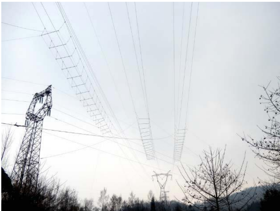
封网跨越实例图
