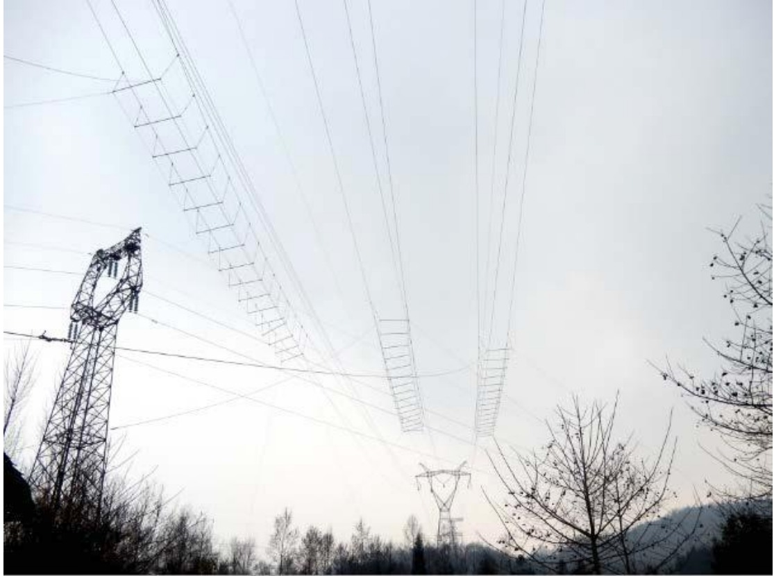
封网跨越实例图
