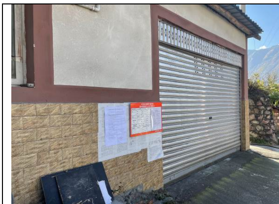
冷碛镇甘露寺村 3 组
