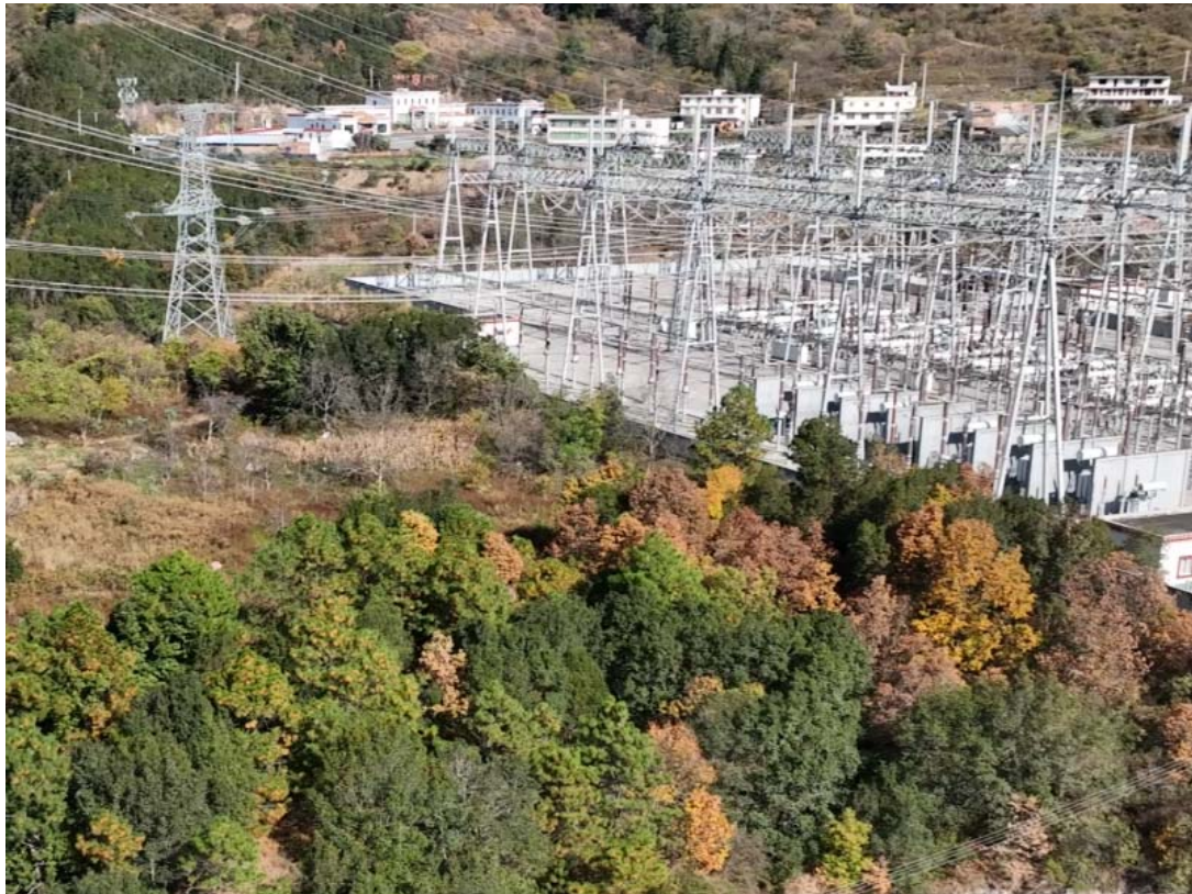
甘谷地开关站区北侧情况
