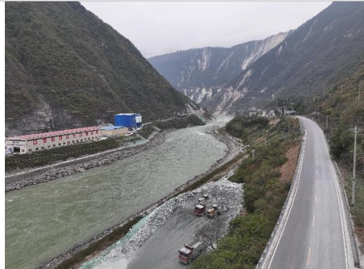
德威镇沙坝村附近水电站施工道路
