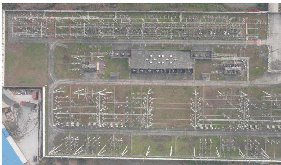
图 3-2 已建玉观 220kV 变电站现状
