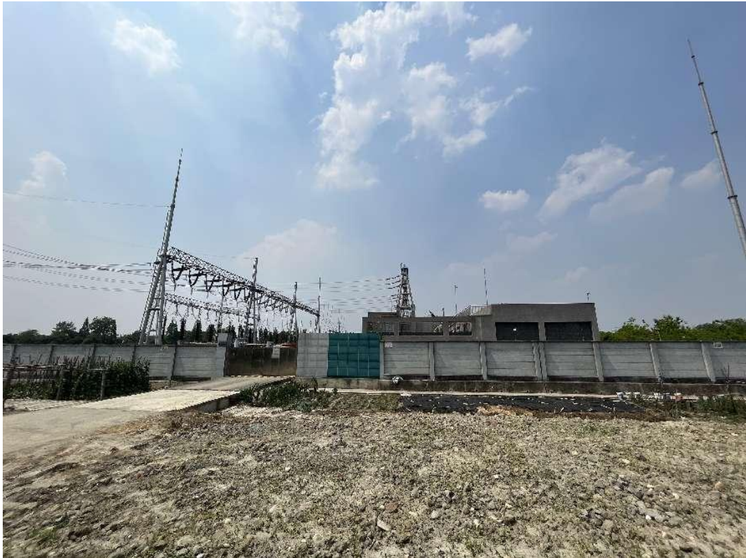
图 3-5 已建黄水 220kV 变电站现状
