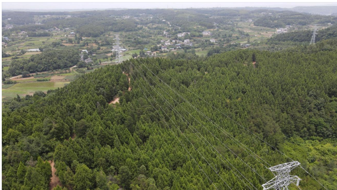
图 3-2 已建 110kV 双回线现状照片
