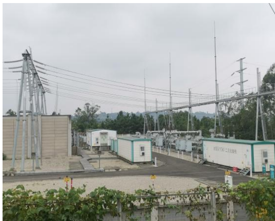
间隔扩建场地现状
