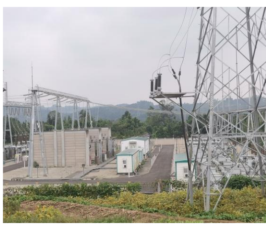
铁佛变现状及已建电缆终端塔
