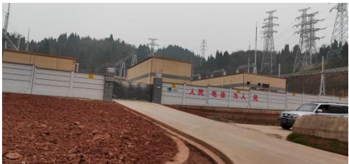
进站道路区场地硬化，两侧施工场地拆除后土地整治
