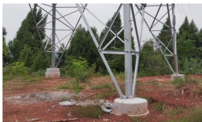
清河~灵泉 27#塔位组塔架线完成
