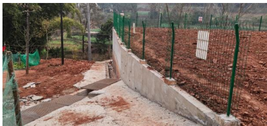
弃渣场西侧排水沟和挡墙
