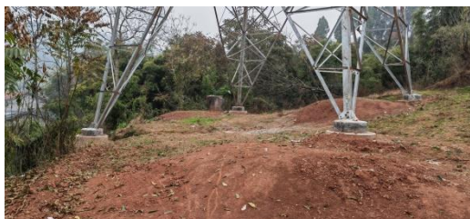
杨胡~灵泉 44#塔位架线完成
