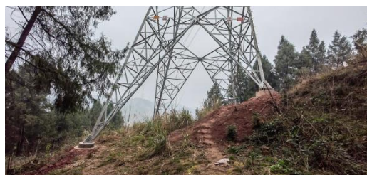
杨胡~灵泉 16#塔位架线完成
