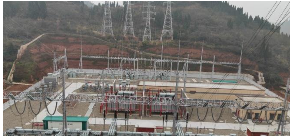
变电站新建工程区场内铺设碎石及边坡防护
