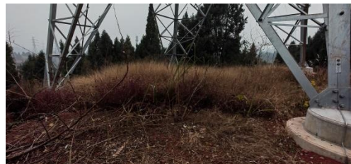
清河~灵泉 7#塔位组塔架线完成
