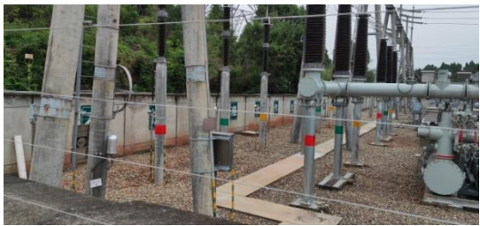
清河 220kV 变电站间隔扩建工程区碎石铺设
