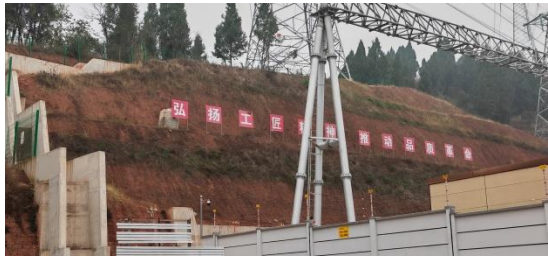
变电站新建工程区截水沟和边坡整治
