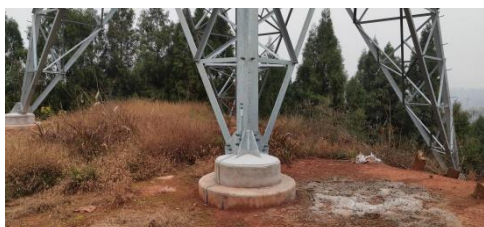
清河~灵泉 3#塔位组塔架线完成
