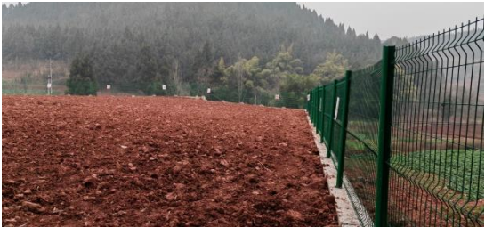
弃渣场东侧挡墙和顶面土地平整
