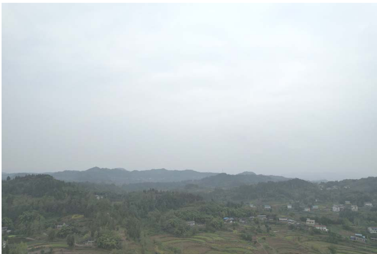
开江 220kV 变电站出线方向
