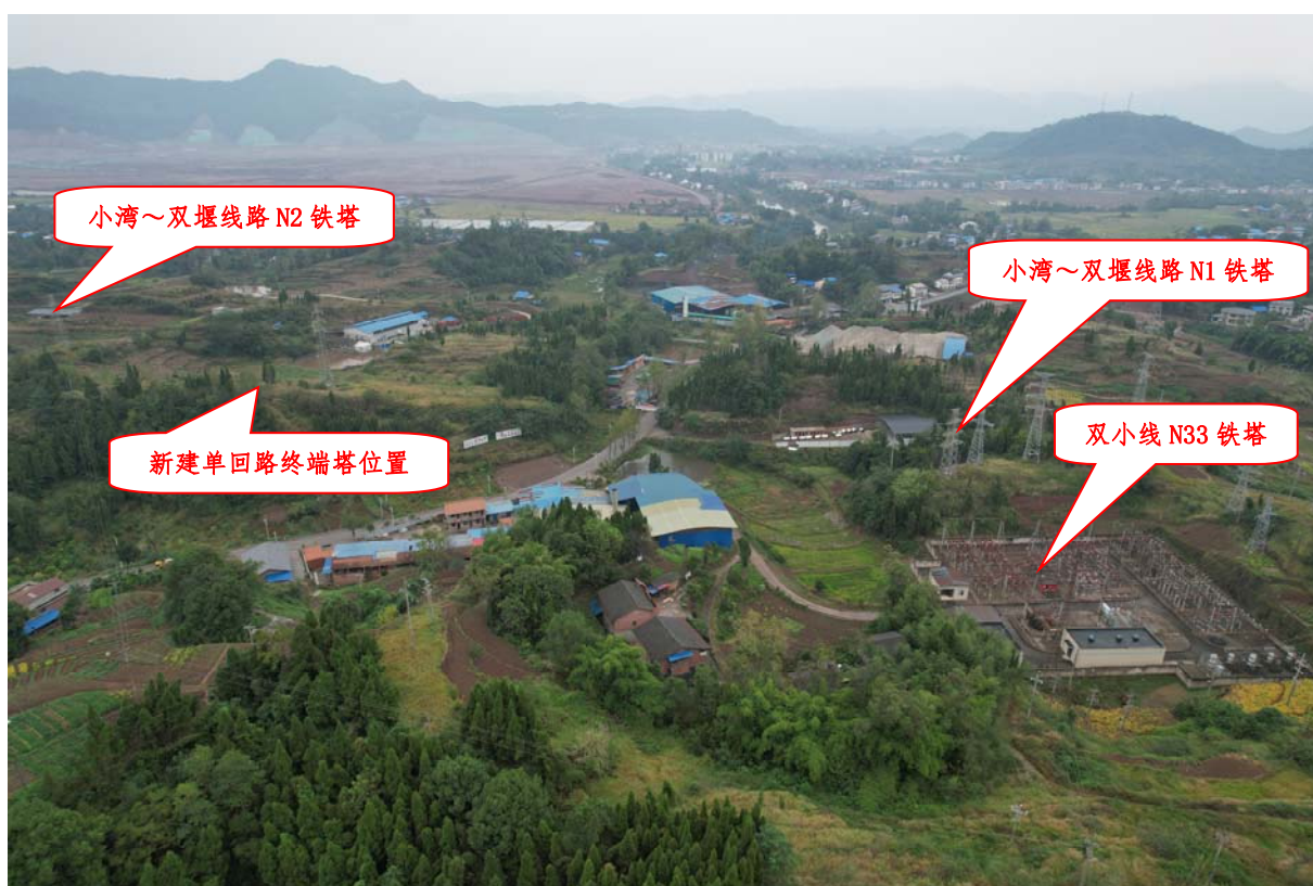
小湾~双堰 T 接麻柳牵引站 110kV 线路改接点现状
