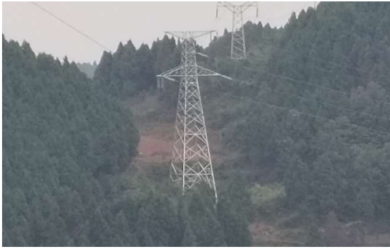
N66+2 号塔现状
