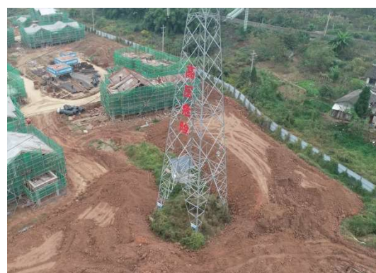
N33G 号塔现状(周边为建筑工地临时堆土)
