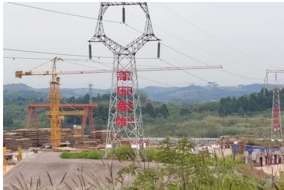
N116G 号塔现状
