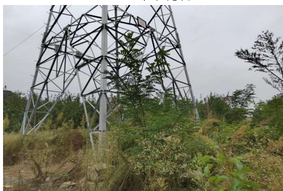
N34G 号塔现状
