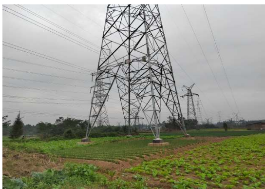
(1) N4G 号塔现状
