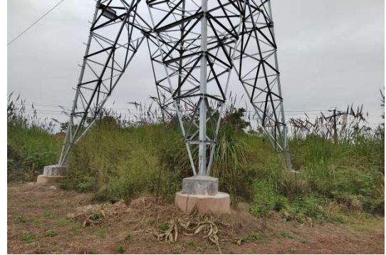
N115G 号塔现状
