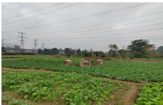
N4 号塔拆除场地现状
