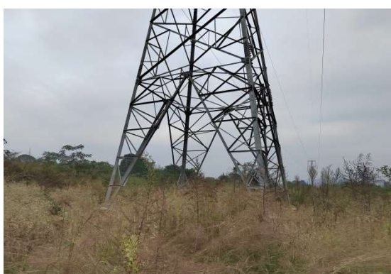
N25+1 号塔现状
