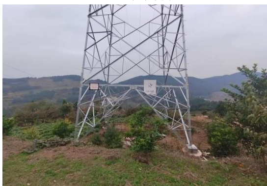
N66G 号塔现状
