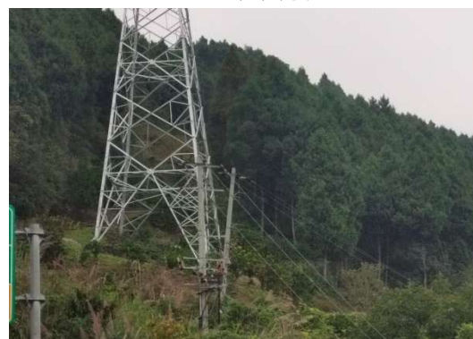
N66+1 号塔现状
