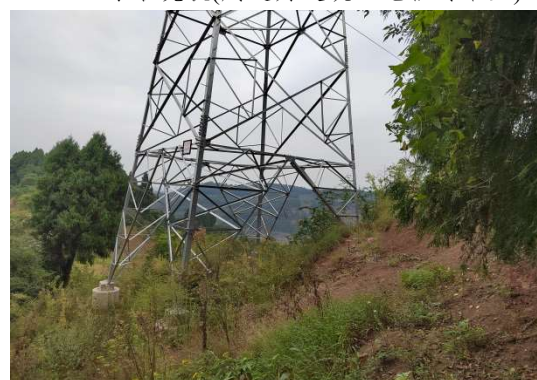
N65G 号塔现状
