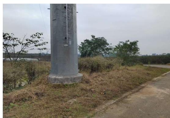
N23+1 号塔现状
