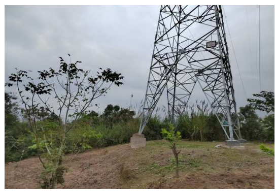
N137+1 号塔现状
