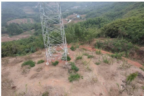
纳震二线改接泰安 N9 塔基施工临时占地恢复
