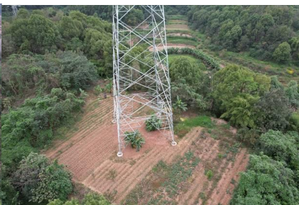
纳震二线改接泰安 N52 塔基施工临时占地复耕
