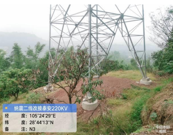
纳震二线改接泰安 N3 塔
