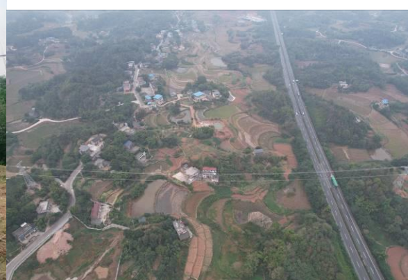
纳震二线改接泰安 N41-42 塔跨高速临时场地恢复
