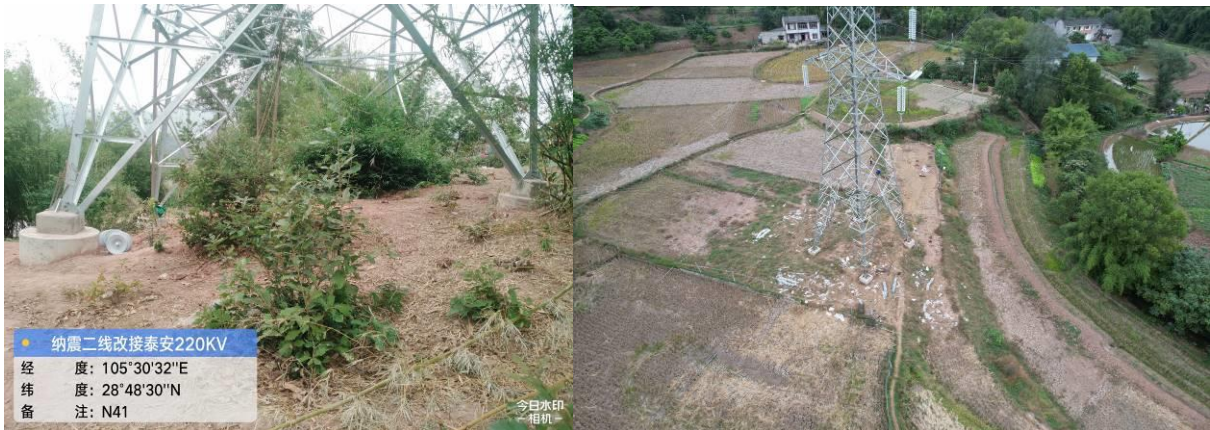
纳震二线改接泰安 N41 塔
