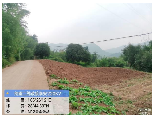
纳震二线改接泰安 N12 塔旁牵张场复耕
