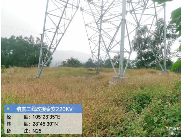
纳震二线改接泰安 N25 塔
