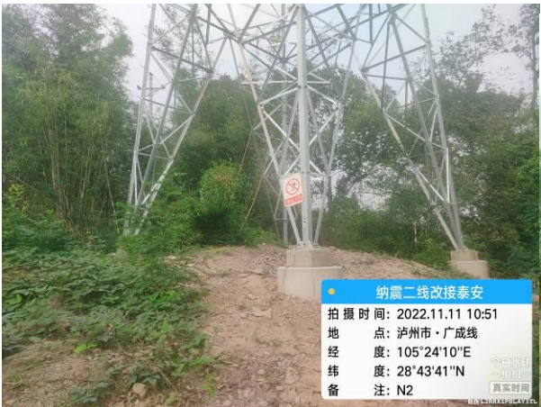
纳震二线改接泰安 N2 塔
