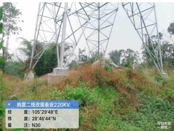
纳震二线改接泰安 N30 塔
