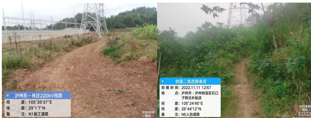
泸州东~林庄 N1 塔施工便道
