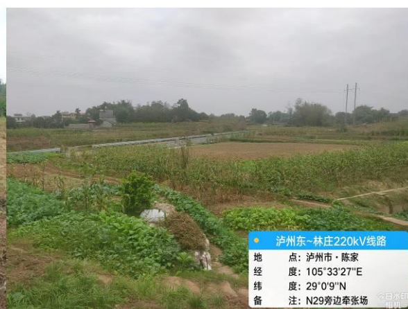
泸州东~林庄 N29 塔旁牵张场复耕
