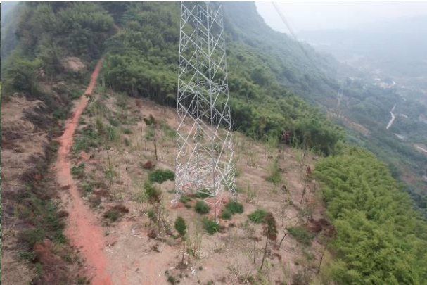
纳震二线改接泰安 N8 塔
