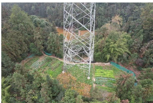
纳震二线改接泰安 N26 塔基施工临时占地复耕
