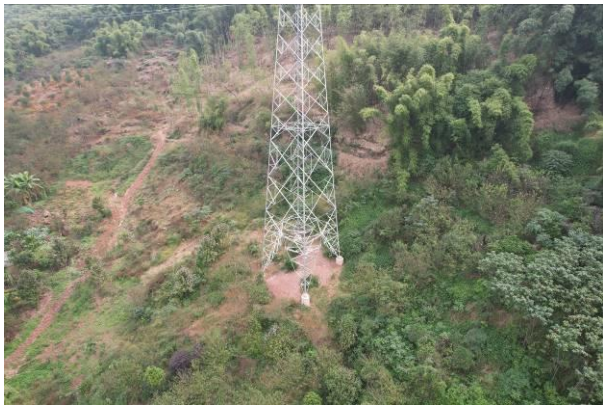
纳震二线改接泰安 N6 塔
