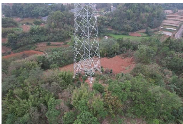
纳震二线改接泰安 N43 塔基施工临时占地恢复
