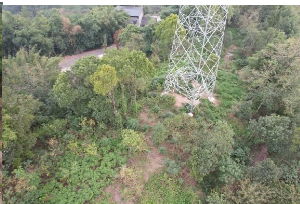
纳震二线改接泰安 N24 塔基施工临时占地恢复
