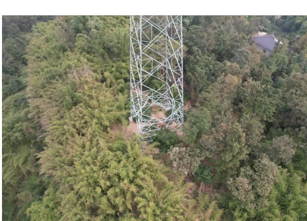
纳震二线改接泰安 N13 塔
