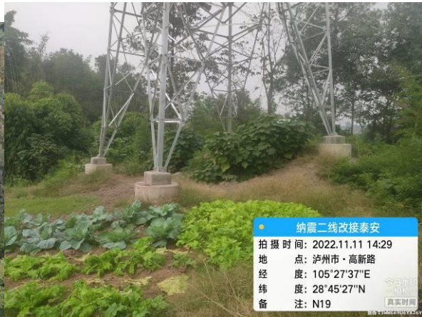
纳震二线改接泰安 N19 塔
