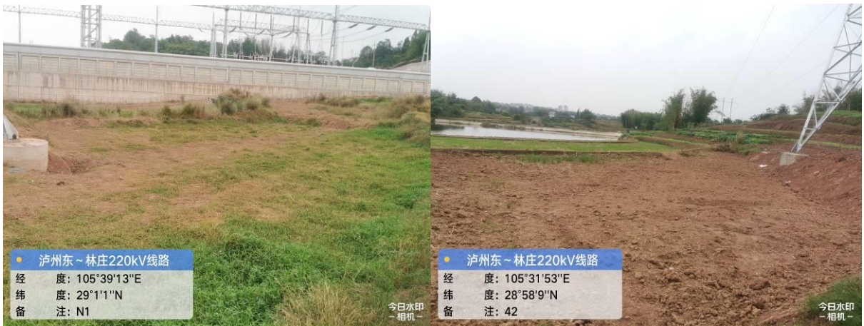
泸州东~林庄 N1 塔基施工临时占地植被恢复
