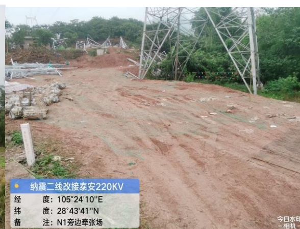
纳震二线改接泰安 N1 塔旁牵张场临时苫盖
