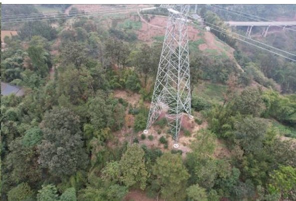
纳震二线改接泰安 N27 塔基施工临时占地恢复
