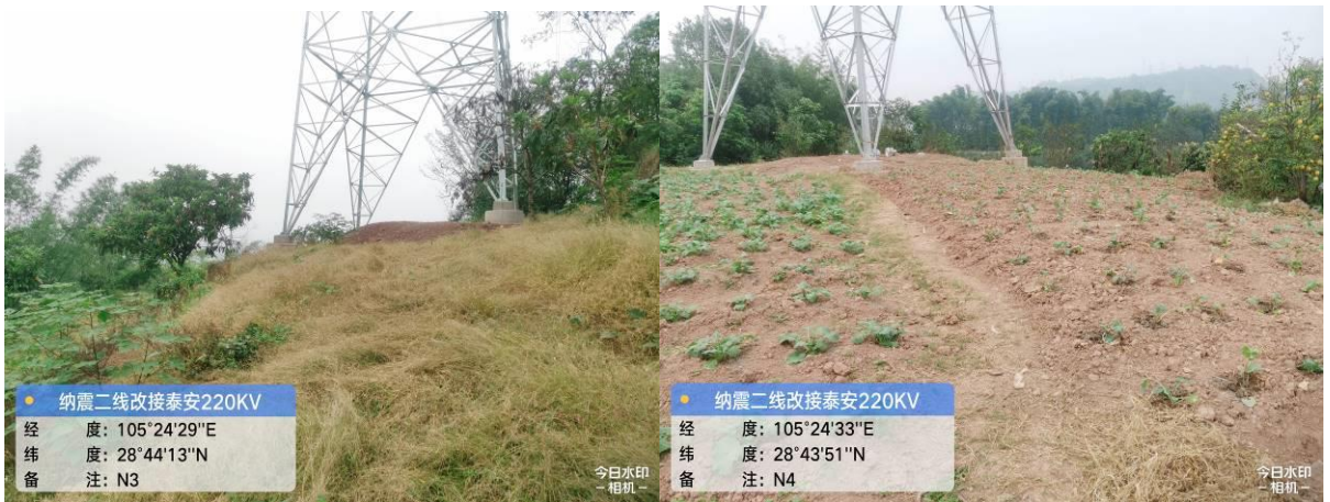
纳震二线改接泰安 N3 塔基施工临时占地植被恢复
