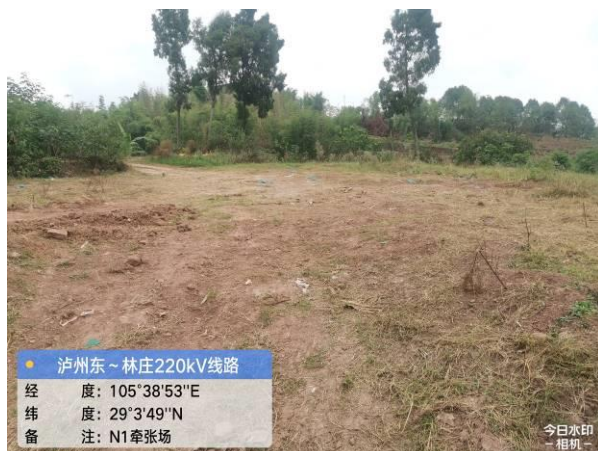
泸州东~林庄 N1 塔旁牵张场清理恢复
