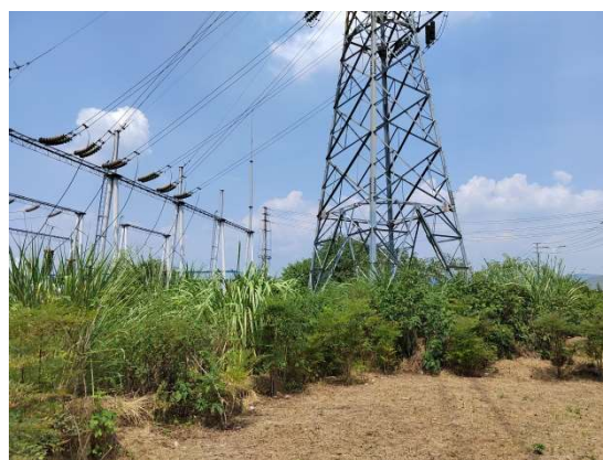
N15 号塔现状
