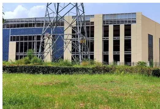
N13 号塔现状
