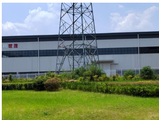
N14 号塔现状
