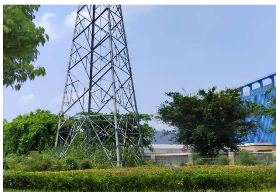
N9 号塔现状
