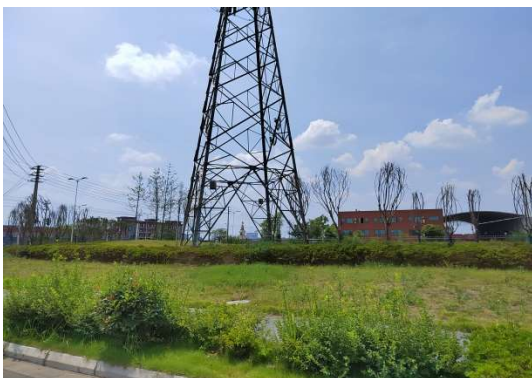
N6 号塔现状
