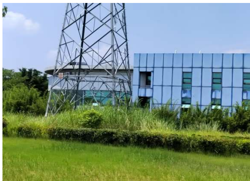
N10 号塔现状
