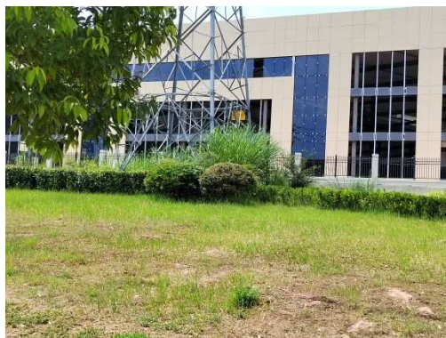
N12 号塔现状
