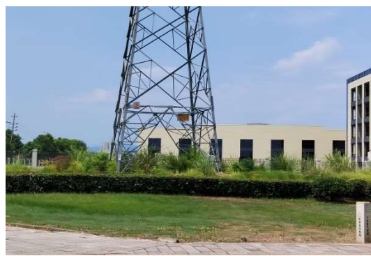
N11 号塔现状
