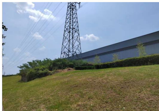
N4 号塔现状
