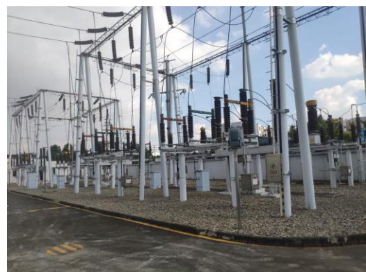
图 6 110kV 户外 AIS 配电装置
