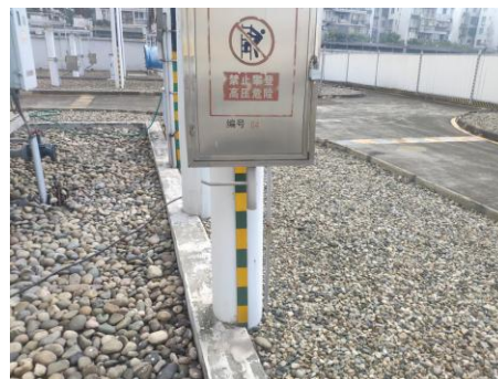
图 17 新都工业东区变电站电气设备接地
