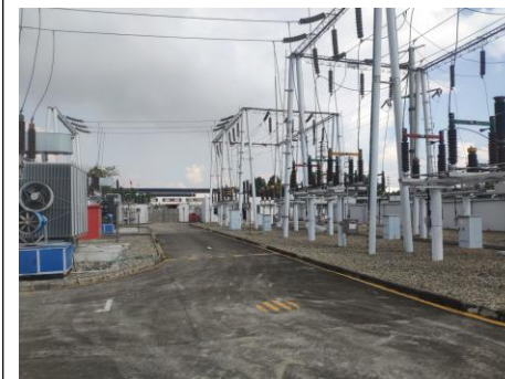
图 18 新都工业东区变电站 AIS 户外布置
