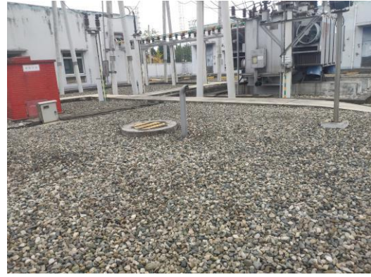
图 26 变电站站内事故油池
