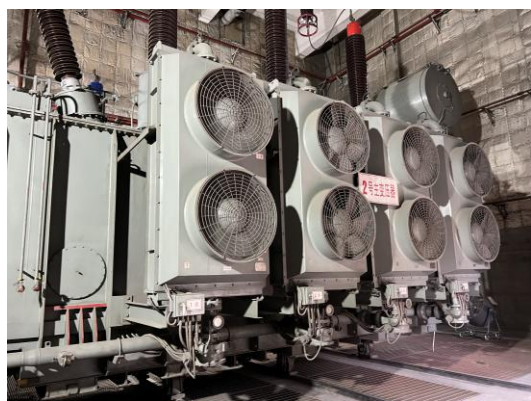
图 15 塘坎街 220kV 变电站本次扩建 2#主变
