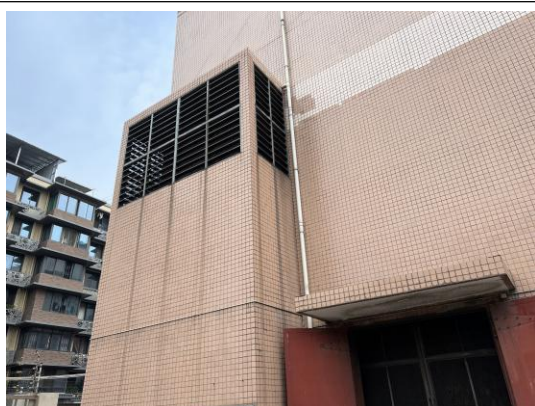
图 5 变电站站内消音百叶窗（2#主变）
