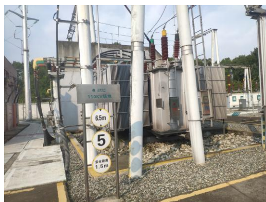
图 2 变电站主变压器
