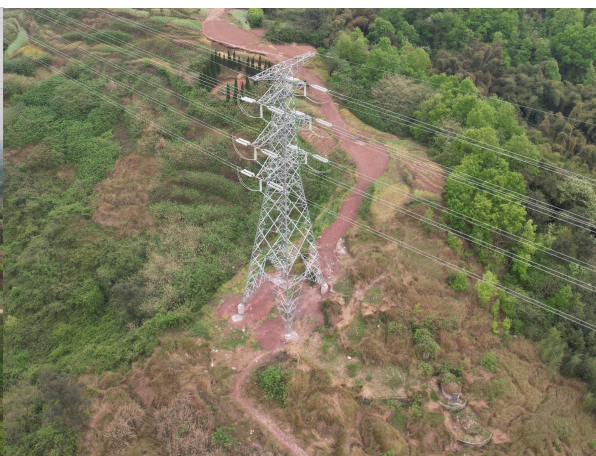
泸州东~罗盘山 N31 塔基施工临时占地植被恢复
