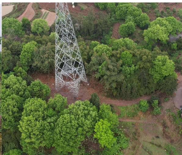
泸州东~泰安 N71 塔基施工临时占地植被恢复
