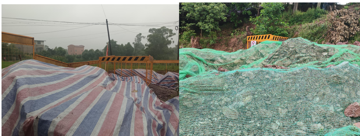
泸州东~林庄 N17 塔临时堆土苫盖
