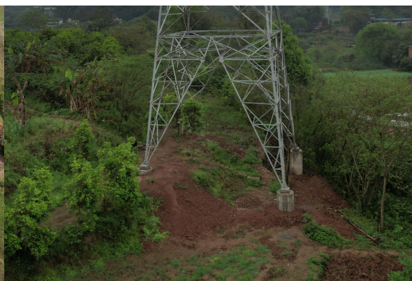
泸州东~泰安 N59 塔基施工临时占地植被恢复
