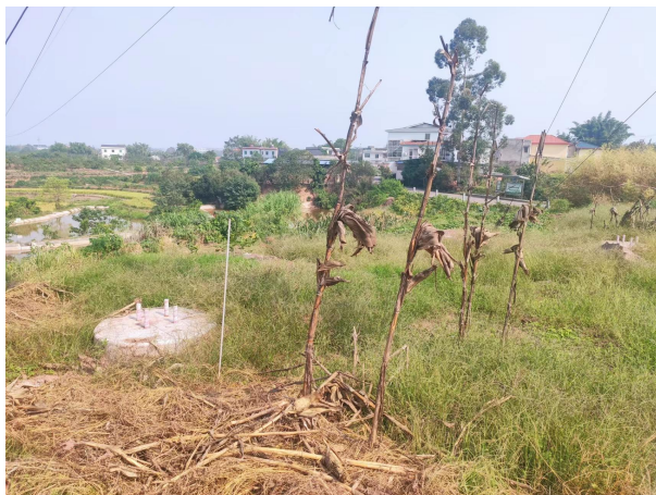
泸州东~林庄 N45 塔
