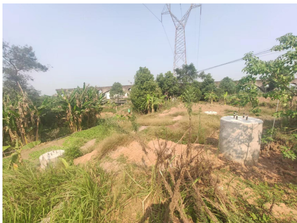
泸州东~林庄 N50 塔
