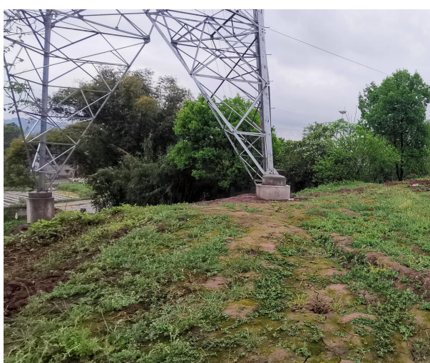
泸州东~泰安 N64 塔基施工临时占地植被恢复
