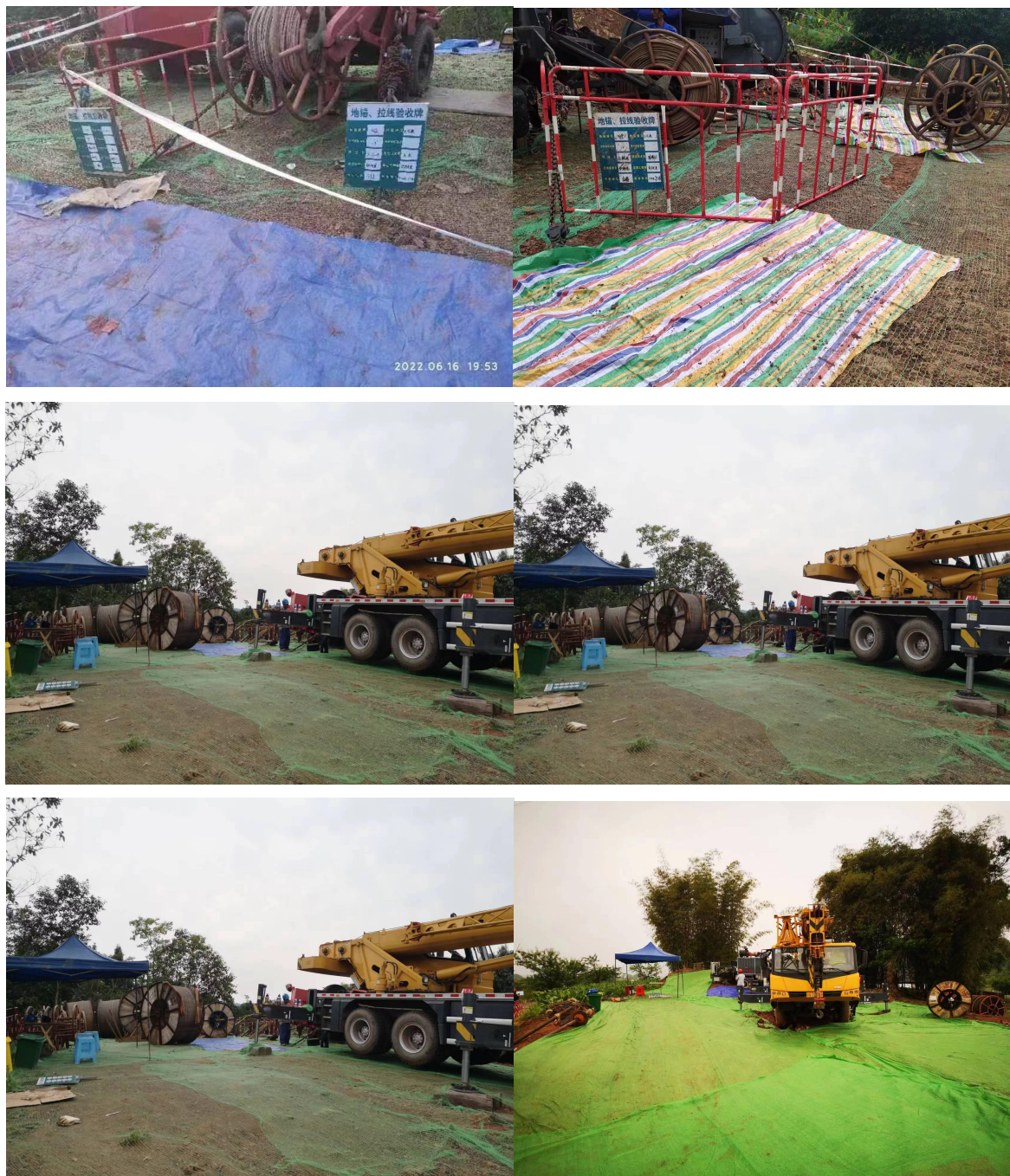
泸州东~震东二线改接泰安牵张场
