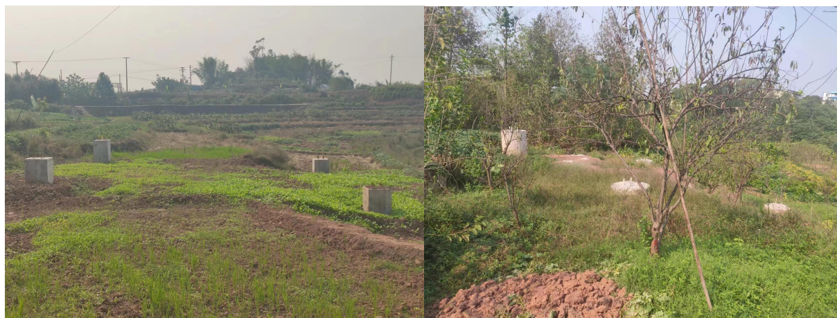
泸州东~林庄 N41 塔
