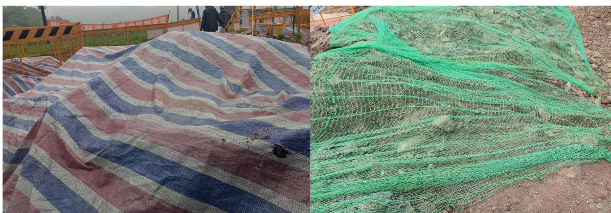
泸州东~林庄 N1 塔临时堆土苫盖
