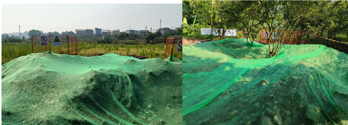
施工临时堆土苫盖
