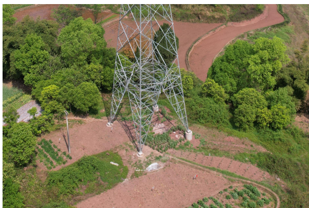
泸州东~罗盘山 N52 塔基施工临时占地复耕
