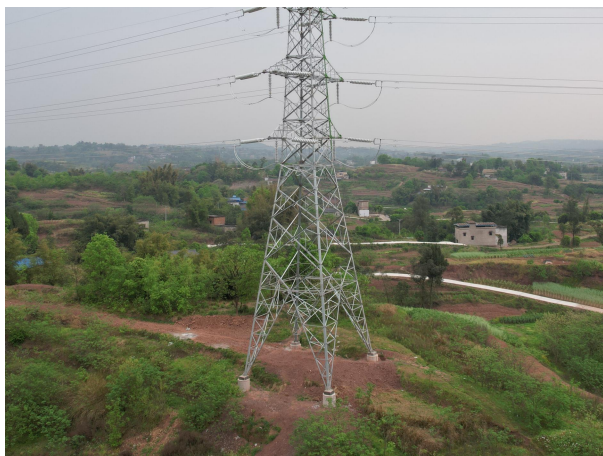
泸州东~罗盘山 N21 塔基施工临时占地植被恢复
