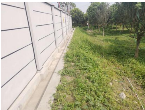
站外排水沟及绿化情况 1
