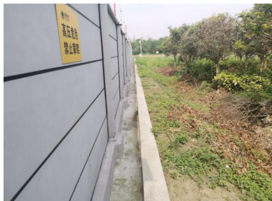
站外排水沟及绿化情况 2
