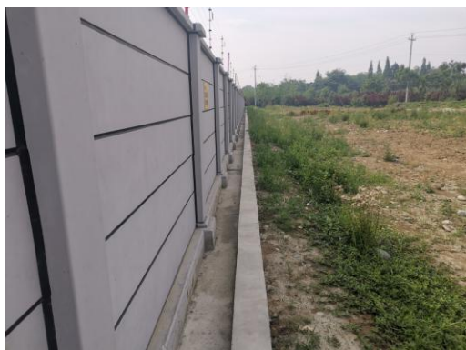
站外排水沟及绿化情况 3
