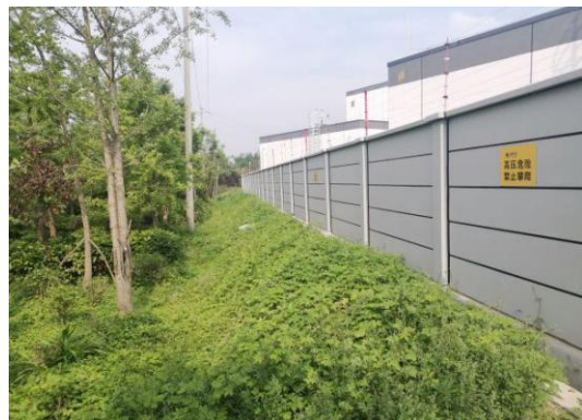
站外排水沟及绿化情况 4
