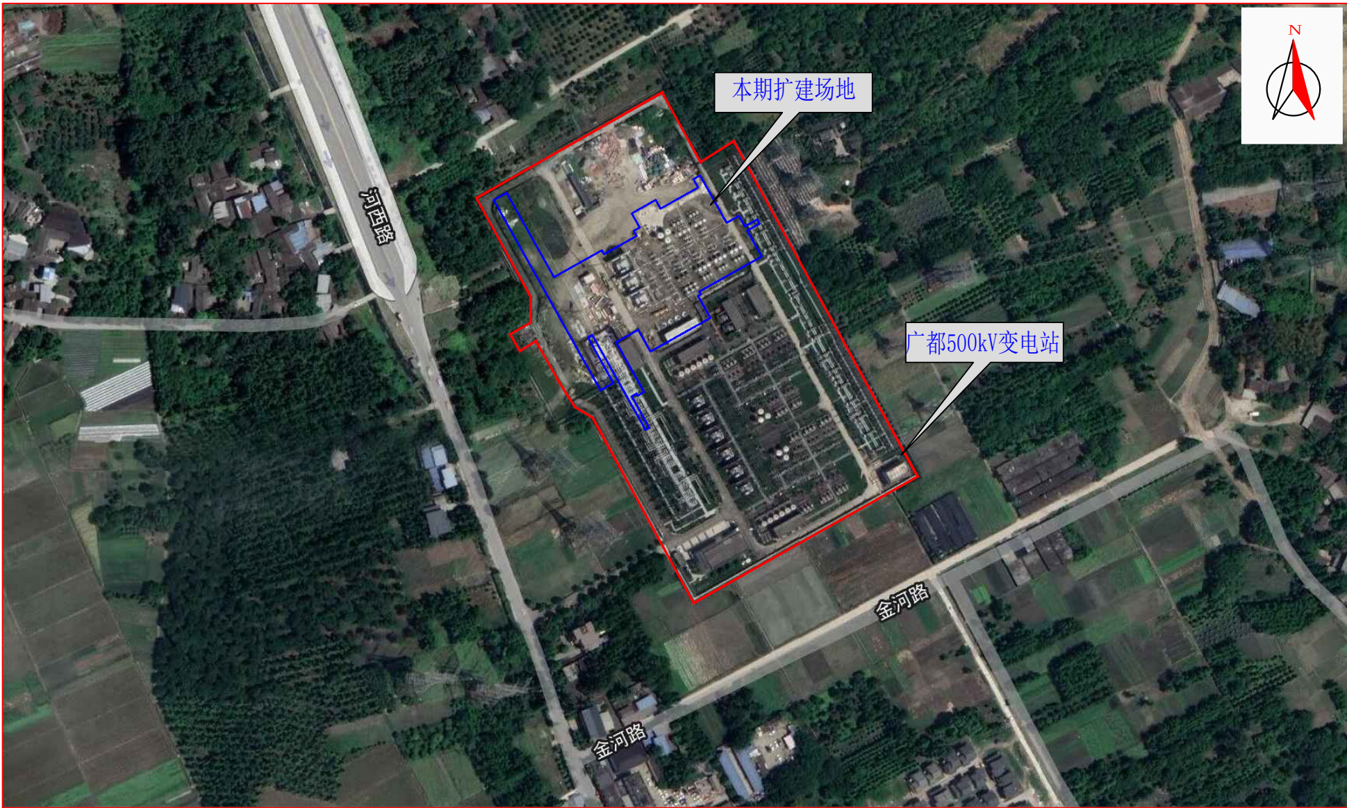
施工中卫星影像图
