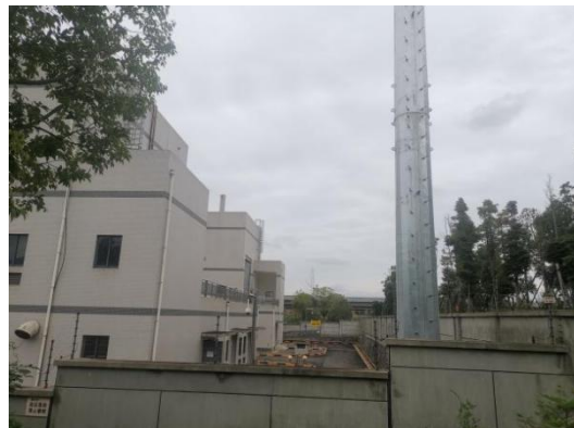
电缆出线站内区域
