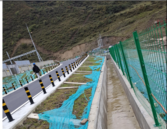
进站道路护坡、排水沟
