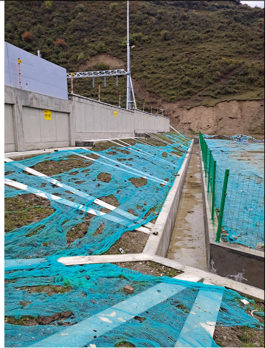
站外护坡、排水沟
