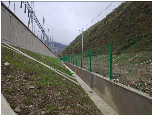
站外护坡、排水沟
