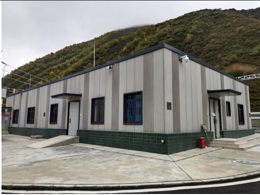
川主寺变电站
