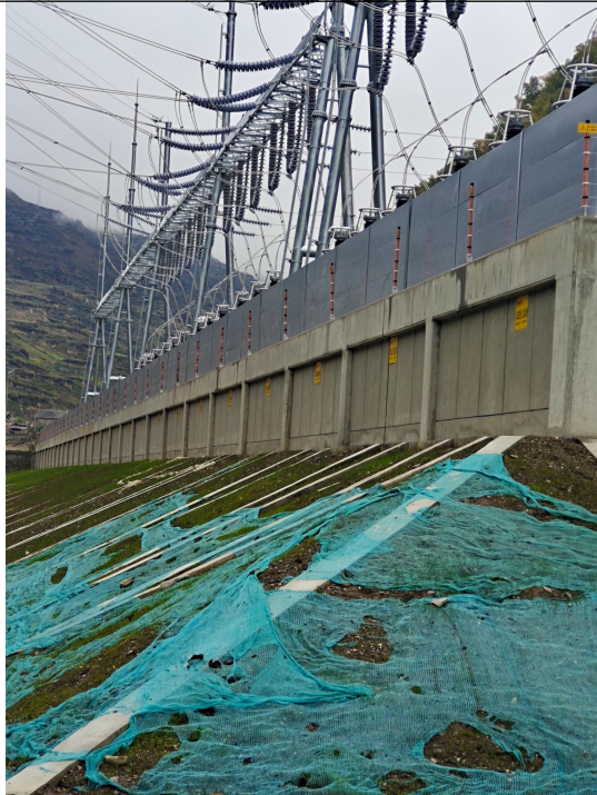
站外综合护坡
