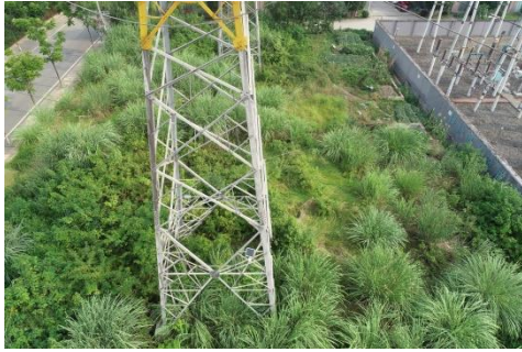
塔基现状（连回线 001#）
