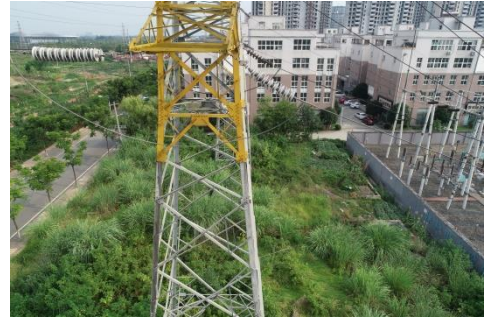
万家变电站外临时用地堆土绿化
