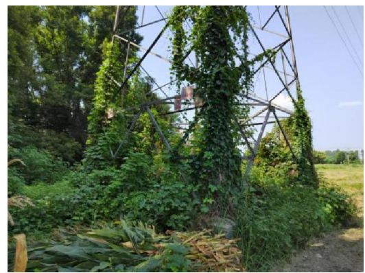
N14 号塔现状
