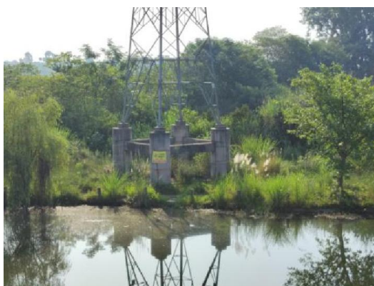
N29 号塔现状
