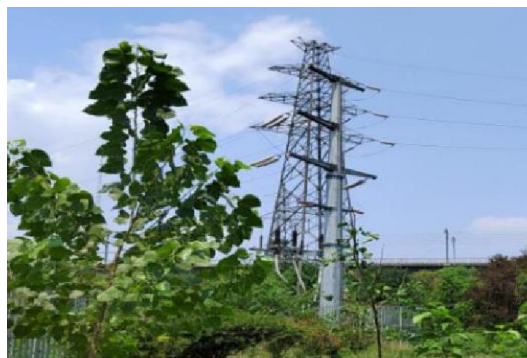
N1号塔现状
