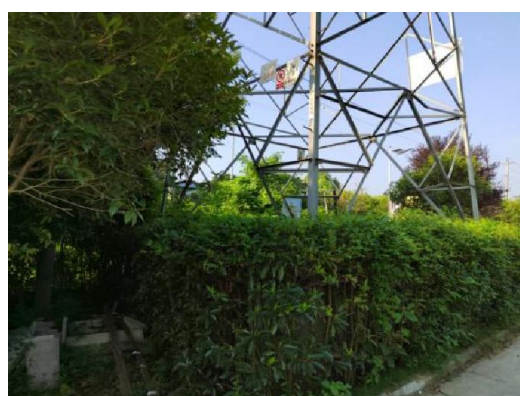
N30 号塔现状
