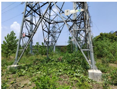
徐顺线铁塔现状
