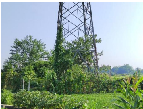
N25 号塔现状
