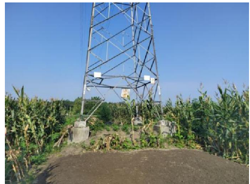
N23 号塔现状
