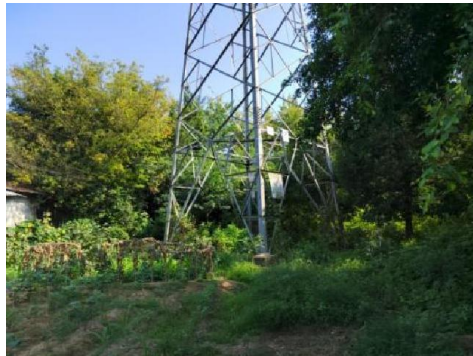
N20 号塔现状
