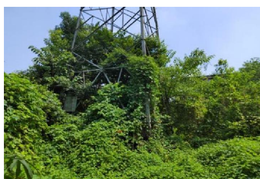
N4号塔现状
