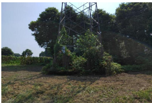
N15 号塔现状
