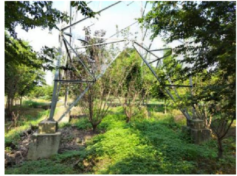
N19 号塔现状
