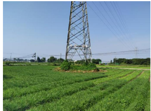
N21 号塔现状
