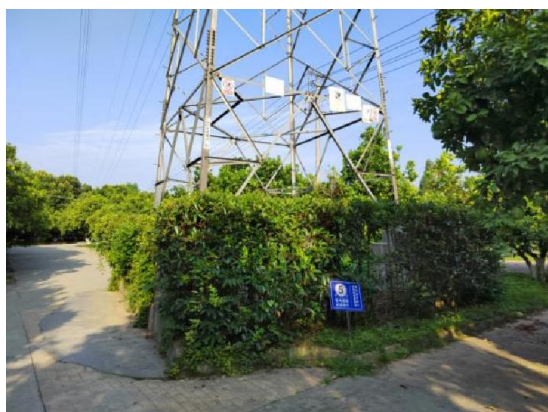
N31 号塔现状
