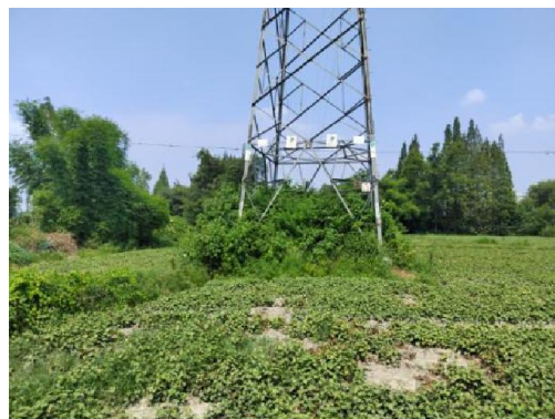
N6号塔现状
