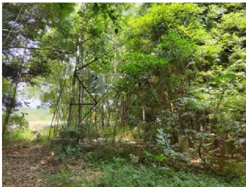
N11 号塔现状
