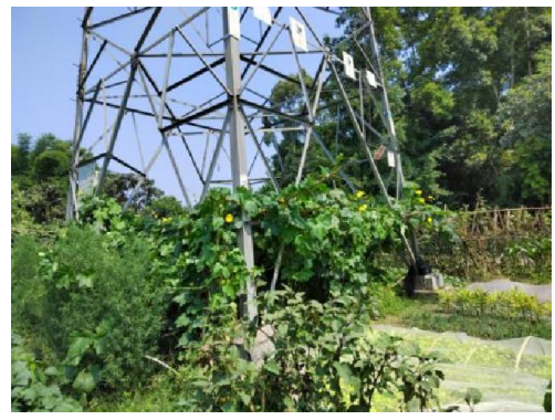
N10 号塔现状
