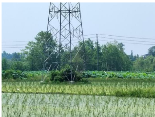
N7号塔现状
