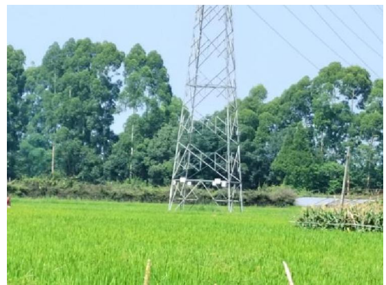
N16 号塔现状
