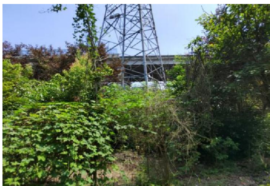
N2号塔现状
