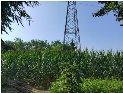
N22 号塔现状
