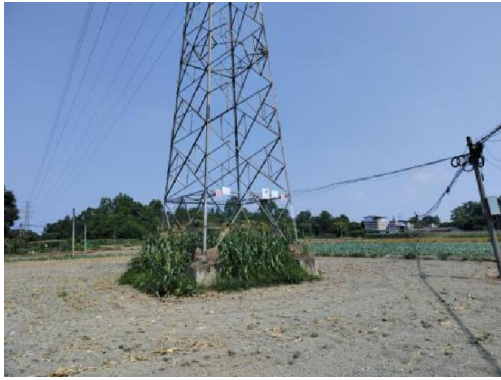
N9 号塔现状
