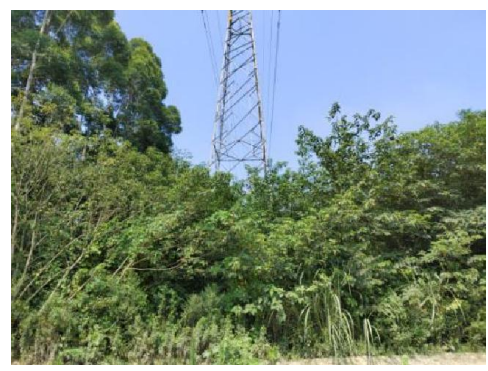
N12 号塔现状
