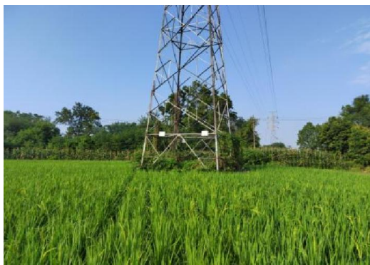
N27 号塔现状
