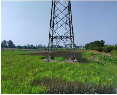
N18 号塔现状
