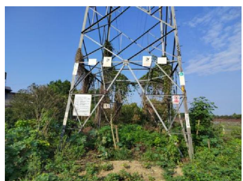
N26 号塔现状
