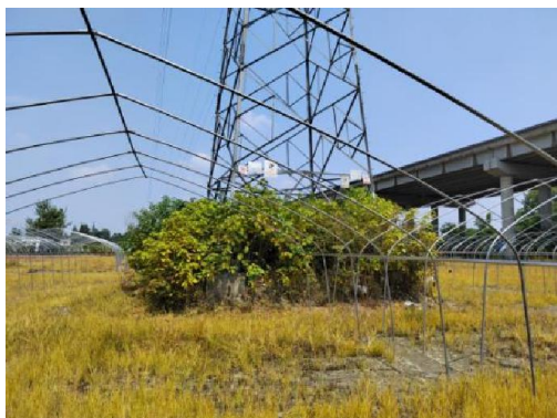
N5号塔现状
