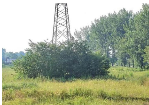
N28 号塔现状
