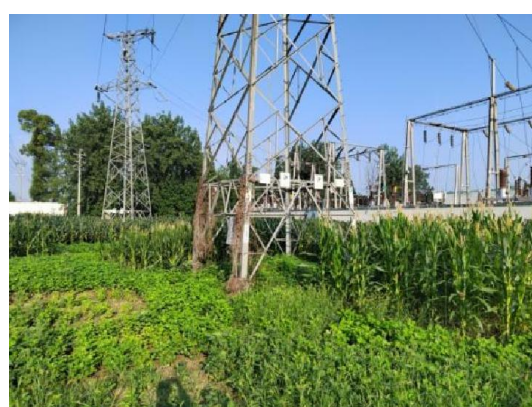
N32 号塔现状
