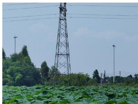
N8号塔现状
