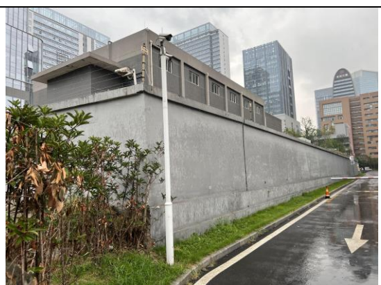
站外排水管网和绿化
