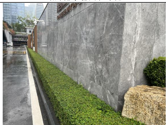
站外排水管网和绿化
