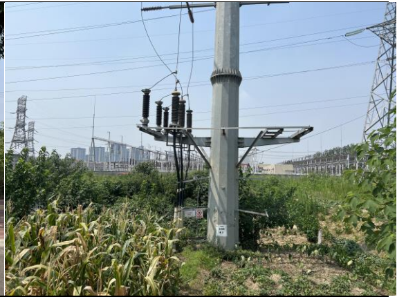
金堂～景峰“π”线路电缆出线 and 1 号塔植被恢复情况
