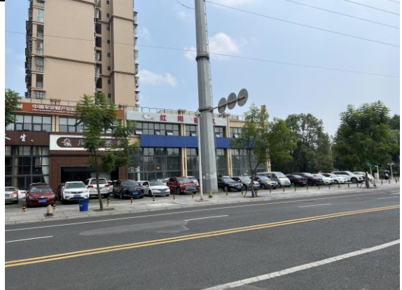
青白江-向阳“T”接线路钢管杆硬化情况
