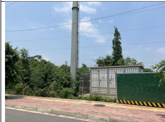
红阳-大同 110kV 线路 8 号塔植被恢复情况
