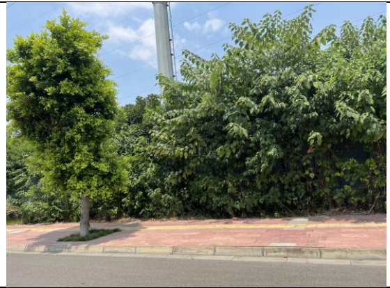
红阳-大同 110kV 线路 5 号塔植被恢复情况
