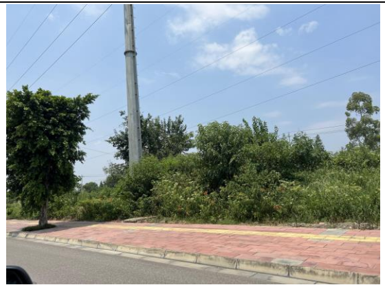
红阳-大同 110kV 线路 7 号塔植被恢复情况
