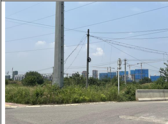
红阳-大同 110kV 线路 10 号塔植被恢复情况
