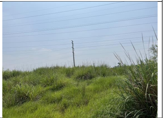
金堂～景峰“π”线路 3 号塔植被恢复情况
