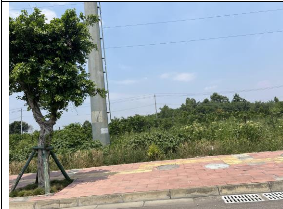
红阳-大同 110kV 线路 6 号塔植被恢复情况
