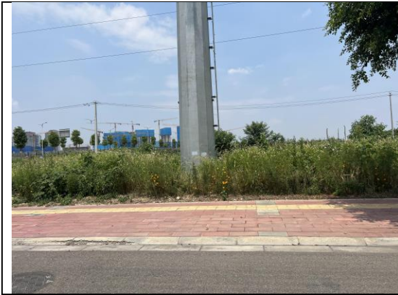
红阳-大同 110kV 线路 12 号塔植被恢复情况
