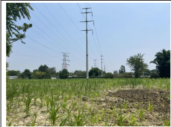
金堂～景峰“π”线路 7 号塔耕地恢复情况
