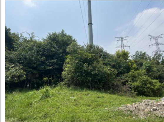
金堂～景峰“π”线路 4 号塔植被恢复情况
