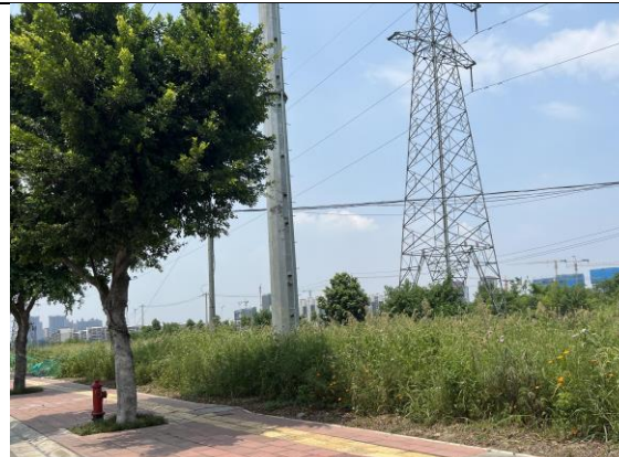
红阳-大同 110kV 线路 11 号塔植被恢复情况
