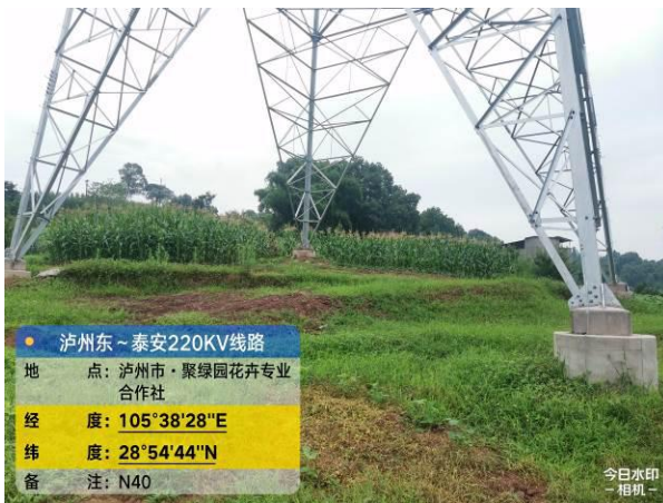
泸州东~泰安 N40 塔基绿化
