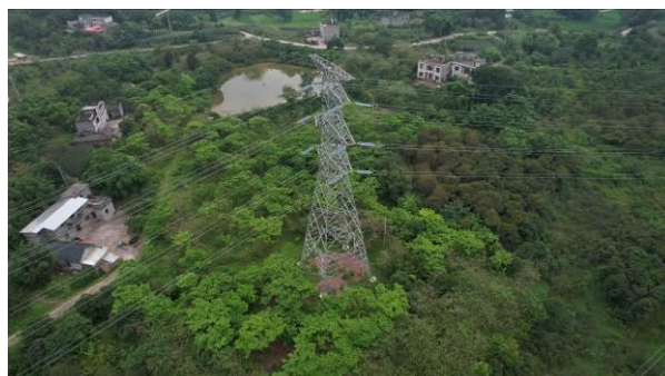
泸州东~罗盘山 N7 塔基施工临时占地绿化
