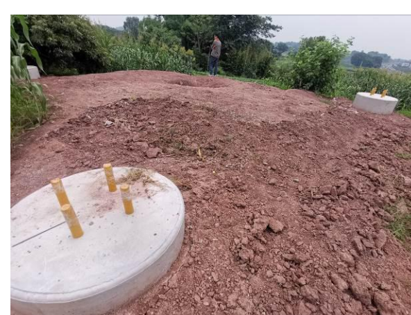
泸州东~林庄 N29 塔基表土剥离、覆土
