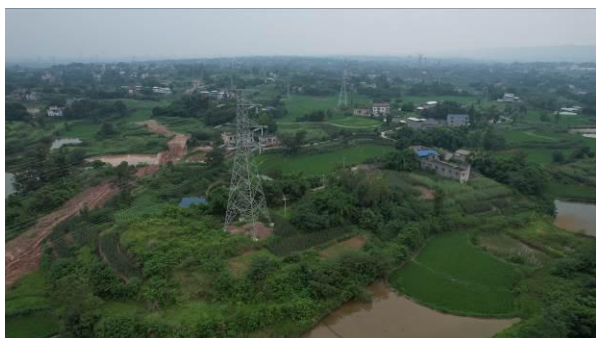
泸州东~罗盘山 N71 塔基施工临时占地绿化
