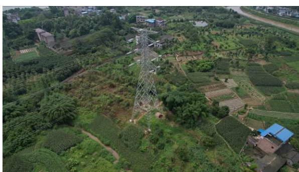
泸州东~泰安 N64 塔基施工临时占地绿化
