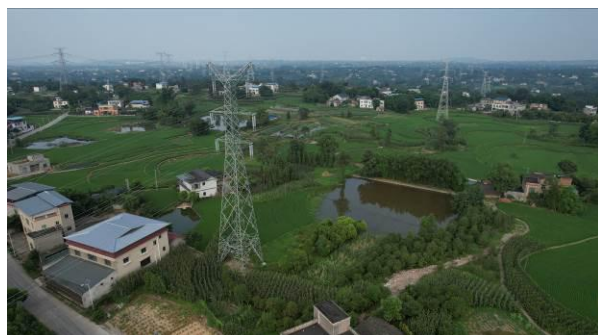
泸州东~罗盘山 N38 塔基施工临时占地复耕
