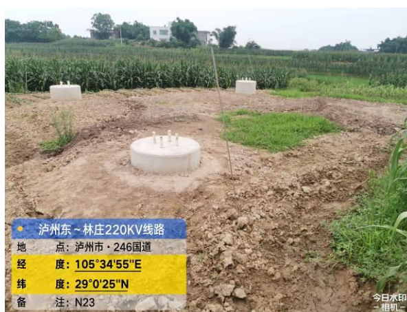
泸州东~林庄 N23 塔基表土剥离、覆土
