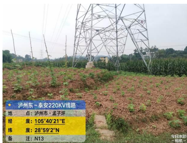
泸州东~泰安 N13 塔基施工临时占地复耕
