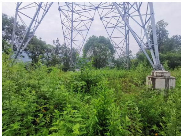
泸州东~泰安 N85 塔基绿化
