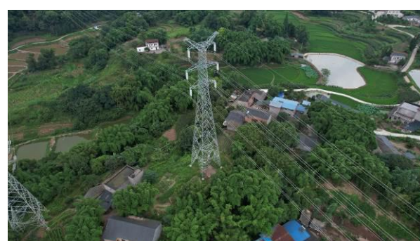
泸州东~泰安 N65 塔基施工临时占地绿化、复耕
