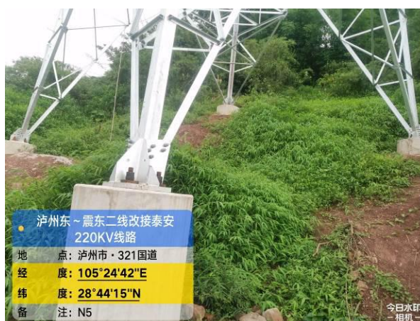
泸州东~震东二线改接泰安 N5 塔基绿化
