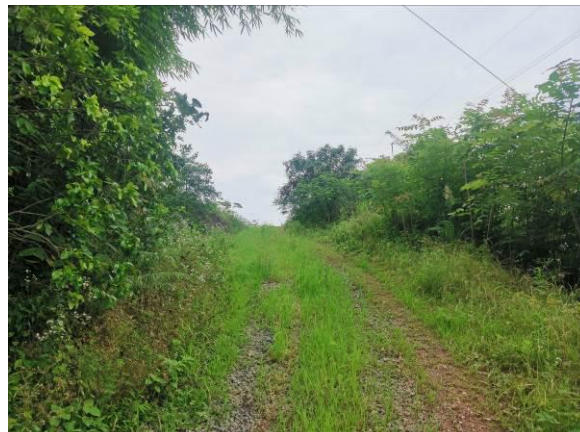
泸州东~泰安 N33 施工便道恢复
