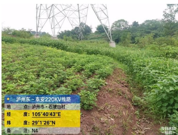
泸州东~泰安 N4 塔基施工临时占地复耕
