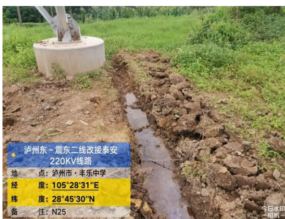
泸州东~震东二线改接泰安 N25 临时排水沟
