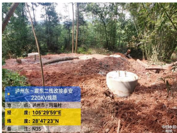
泸州东~震东二线改接泰安 N35 塔基覆土、土地整治
