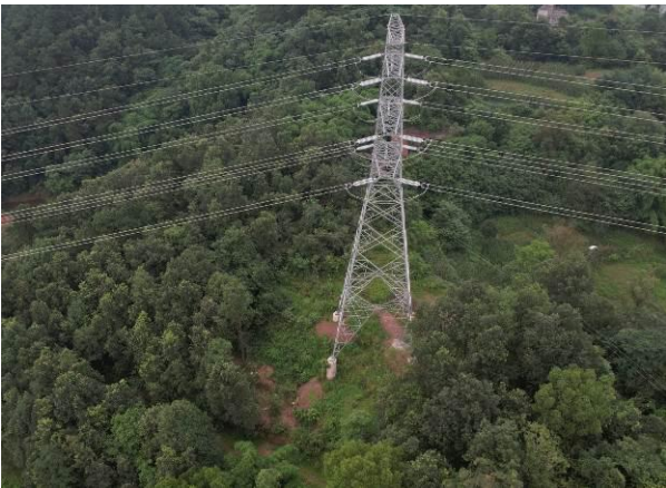
泸州东~泰安 N8 塔基绿化
