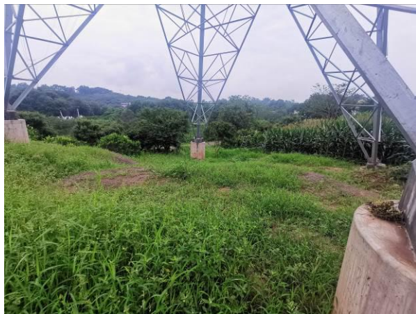
泸州东~泰安 N46 塔基土地整治、覆土
