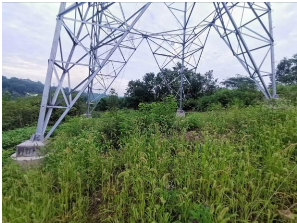
泸州东~泰安 N4 塔基绿化
