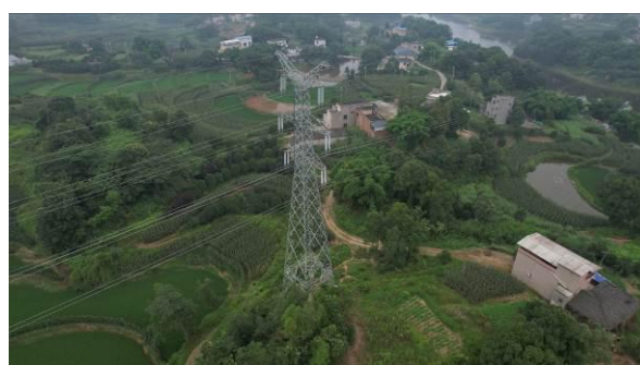
泸州东~罗盘山 N51 塔基施工临时占地绿化
