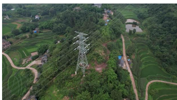
泸州东~泰安 N34 塔基施工临时占地绿化
