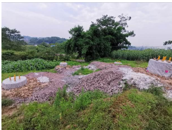
泸州东~林庄 N3 未采取表土剥离及堆存 纳溪~震东二线改接泰安 N44 未及时场地清理、整地
