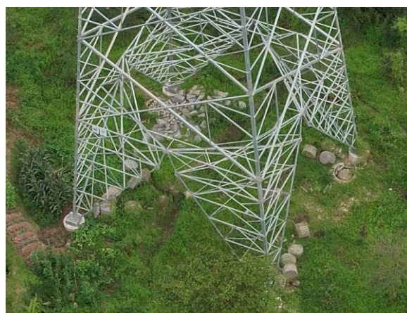
泸州东～罗盘山 N74 基础开挖块石乱堆
