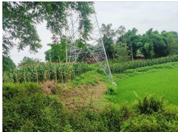
泸州东~罗盘山 N25 塔基施工临时占地复耕
