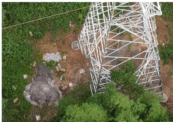
泸州东~林庄 N3 未采取表土剥离及堆存 纳溪~震东二线改接泰安 N44 未及时场地清理、整地
