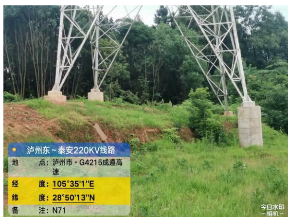
泸州东~泰安 N71 塔基绿化
