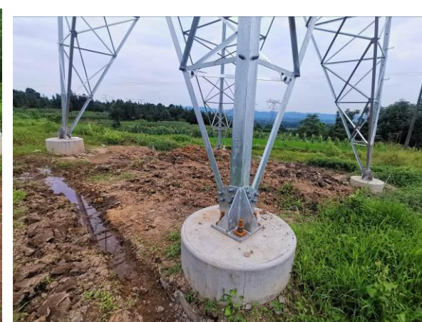
泸州东~震东二线改接泰安 N25 塔基土地整治
