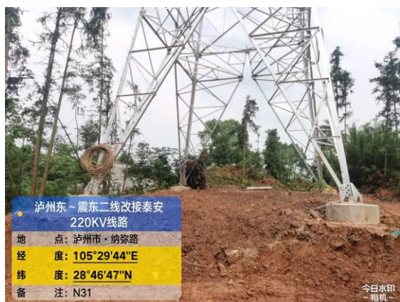
泸州东~震东二线改接泰安 N31 塔基覆土、土地整治
