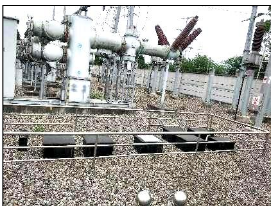
秋月 220kV 变电站生活污水处理设施
