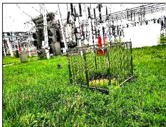
新市 220kV 变电站事故油池
