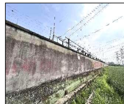
秋月 220kV 变电站站外排水沟
