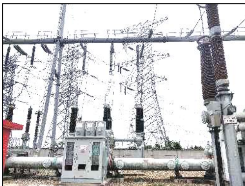
秋月220kV变电站间隔扩建处
