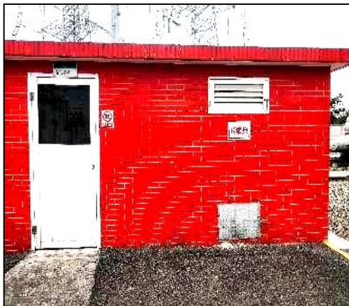
秋月 220kV 变电站消防小室
