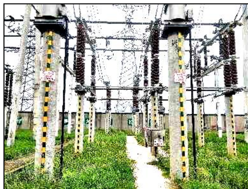
新市220kV变电站间隔扩建处
