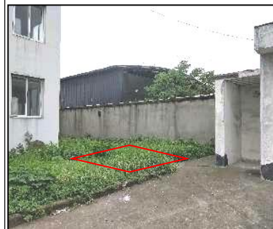
新市 220kV 变电站化粪池
