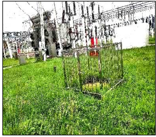
新市 220kV 变电站事故油池
