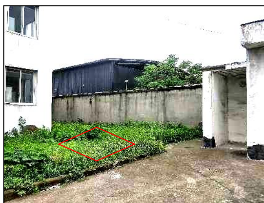
新市 220kV 变电站化粪池
