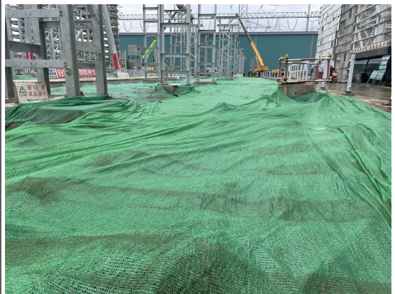
站内裸露地表临时苫盖 (2022.06.30)
