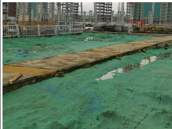
站内密目网苫盖 (2022.06.16)
