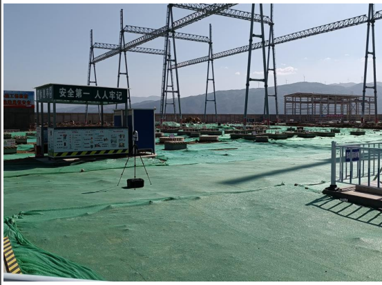
站内密目网苫盖 (2022.03.25)
