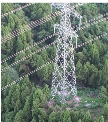
清河~灵泉 27#塔位组塔架线完成
