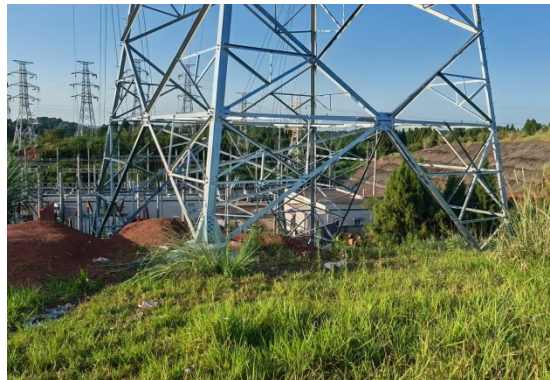
清河~灵泉 2#塔位立塔完成
