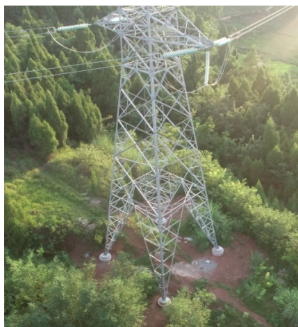
清河~灵泉 7#塔位组塔架线完成
