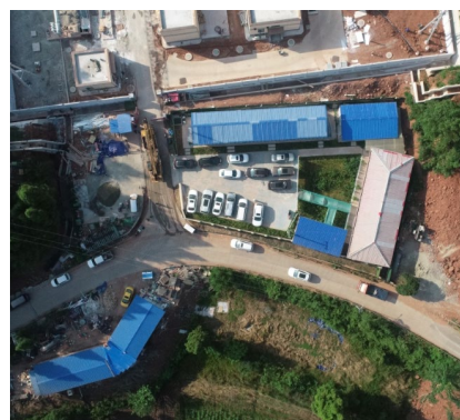
进站道路区场地硬化
