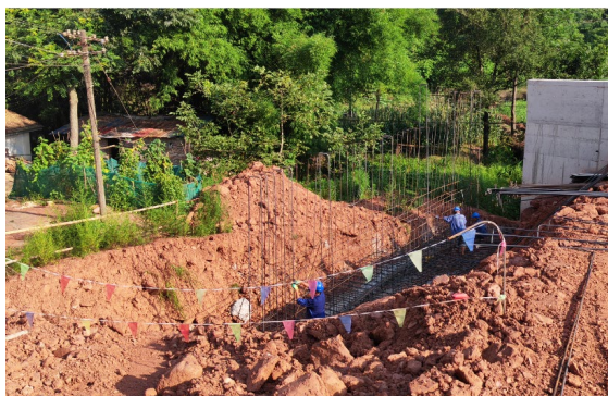
弃渣场挡墙尚未实施完成，渣场未实施复耕和绿化
