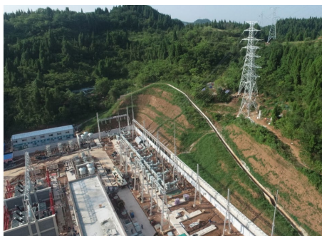
变电站新建工程区截水沟和边坡整治
