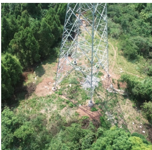
杨胡~灵泉 3#塔位立塔完成
