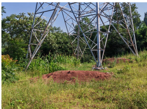
杨胡~灵泉 44#塔位立塔完成
