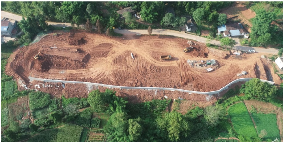
弃渣场堆渣全貌-表土堆存于左侧，挡墙施工中
