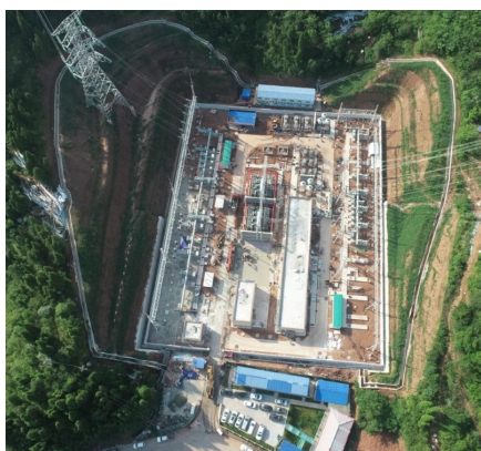
变电站新建工程区场内基础及边坡施工
