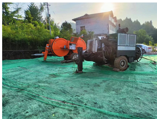
清河~灵泉 48#塔位附近牵张场-临时隔离防护
