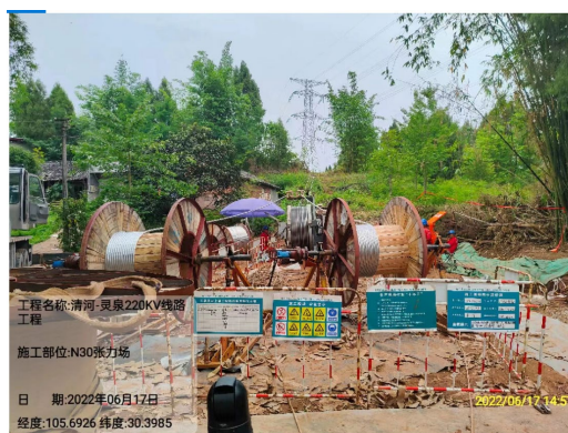
清河~灵泉 30#塔位附近牵张场-临时隔离防护
