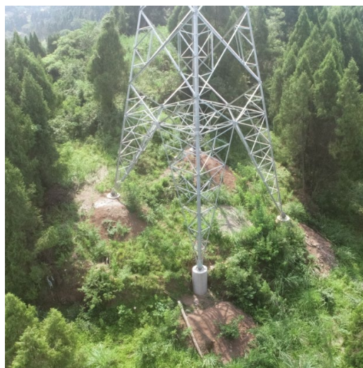
杨胡~灵泉 16#塔位立塔完成
