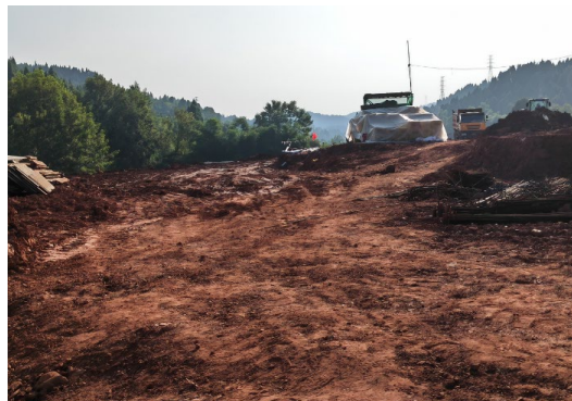
弃渣场挡墙尚未实施完成，渣场未实施复耕和绿化
