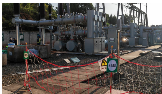
清河 220kV 变电站间隔扩建工程区碎石铺设
