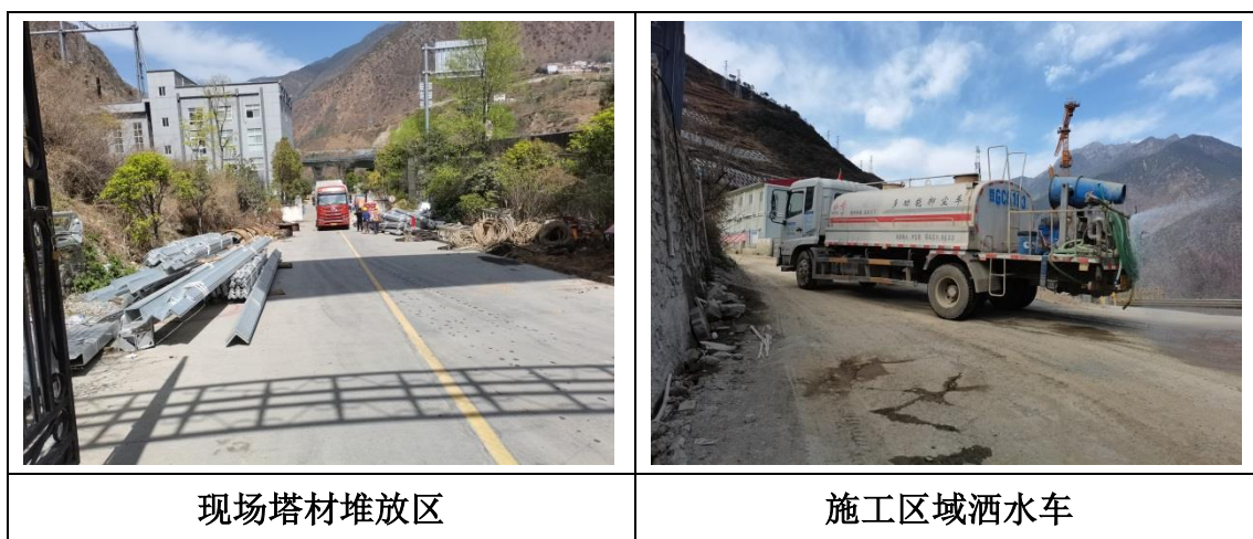
图 7-1 施工期扬尘治理措施
