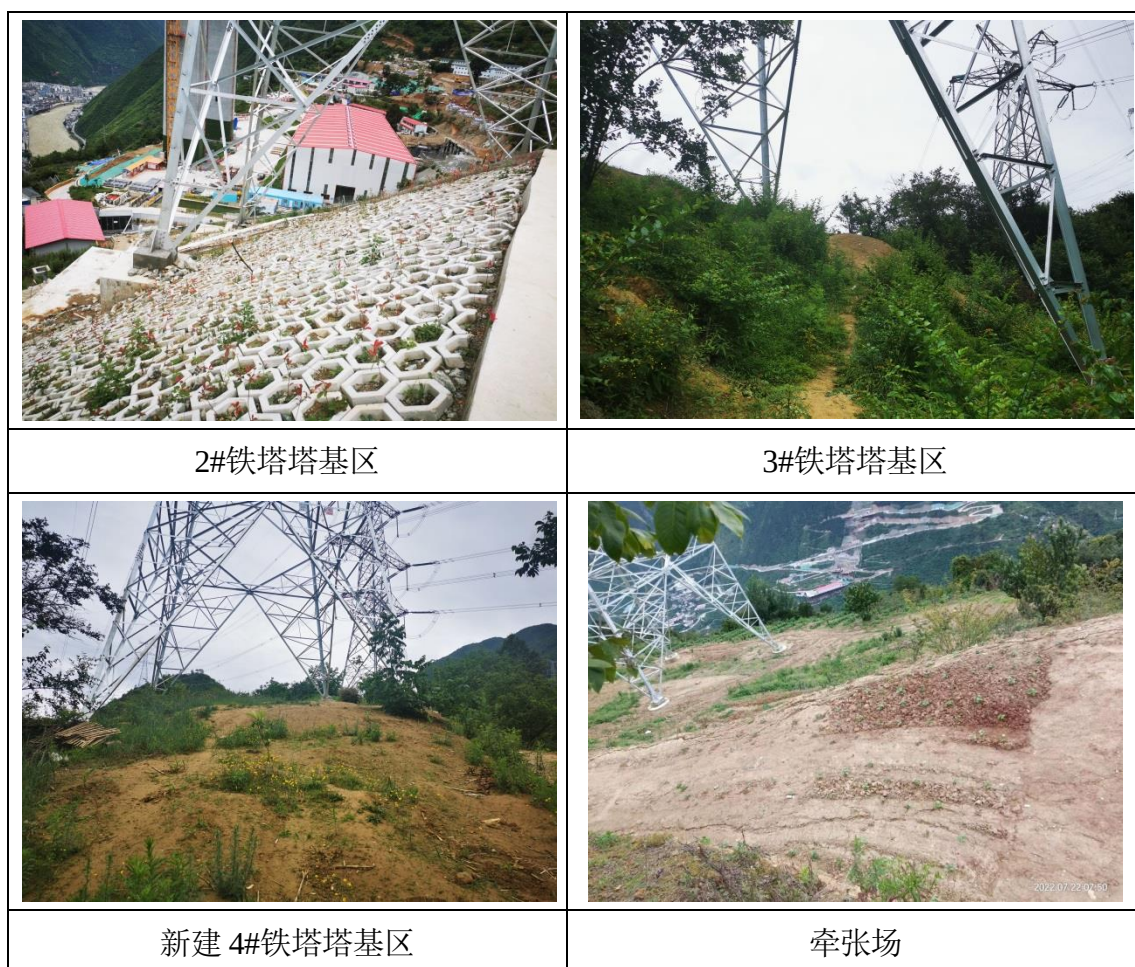
图 5-1 铁塔及基础区域现状
