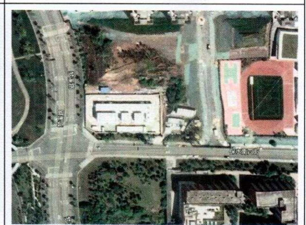
兴隆变电站建设后影像
