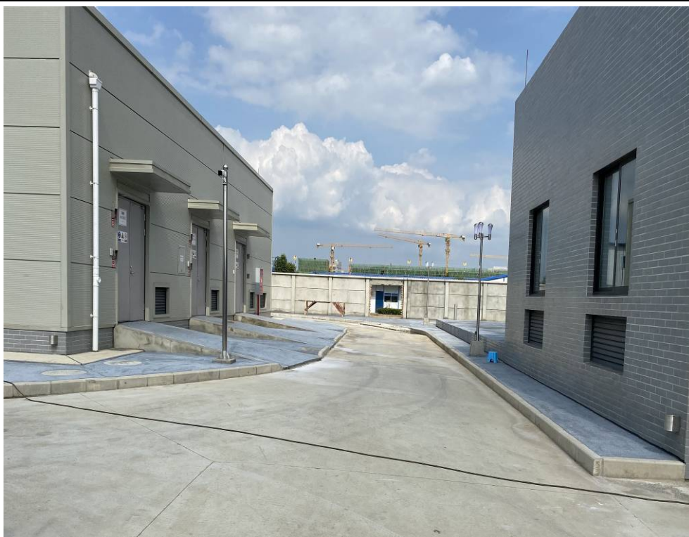
站内建筑物（一）
