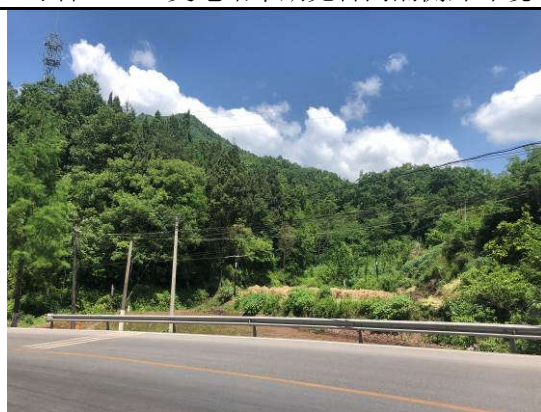
拟建 220kV 线路沿线（玛瑙村 3 组附近）
