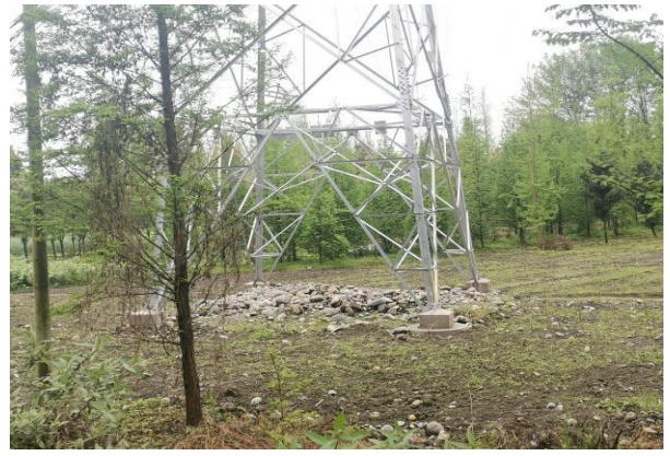
32 号塔植被恢复情况
