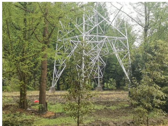
9号塔植被恢复情况
