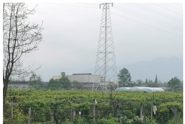
109 号塔植被恢复情况
