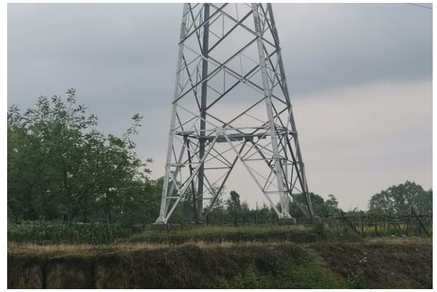
124 号塔植被恢复情况
