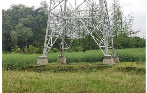
75 号塔植被恢复情况
