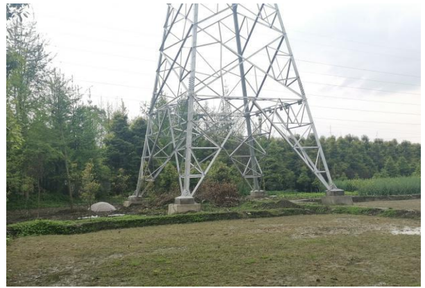
68 号塔植被恢复情况
