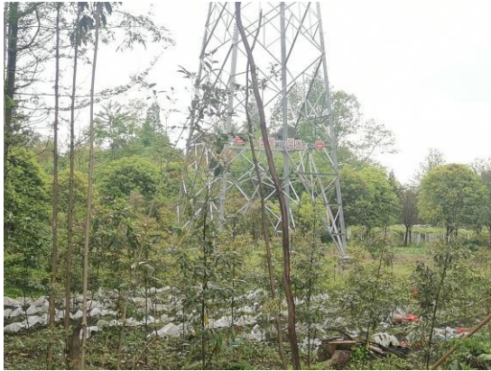
85 号塔植被恢复情况
