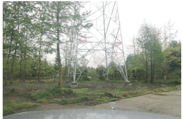
27 号塔植被恢复情况
