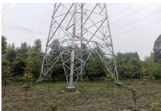
5号塔植被恢复情况
