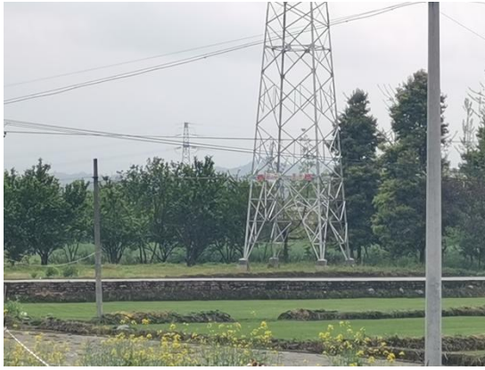
101 号塔植被恢复情况
