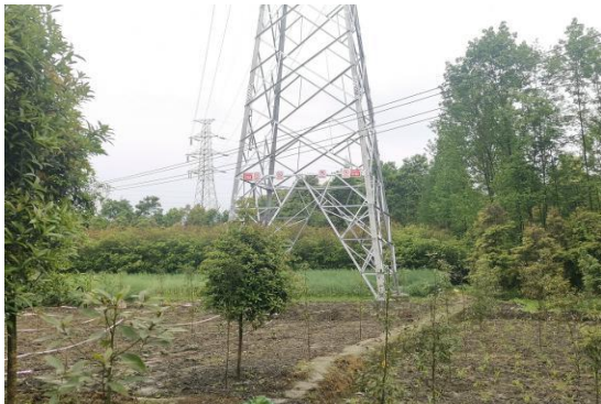
16 号塔植被恢复情况
