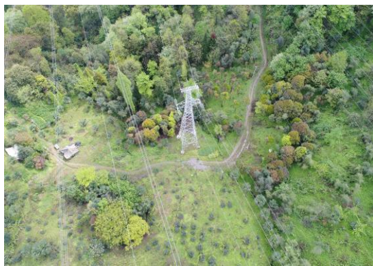
8 号塔植被恢复情况
