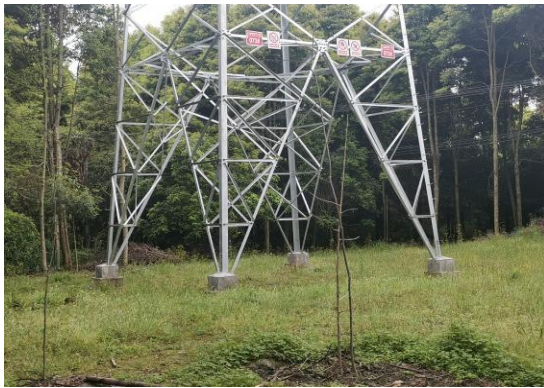
73 号塔植被恢复情况
