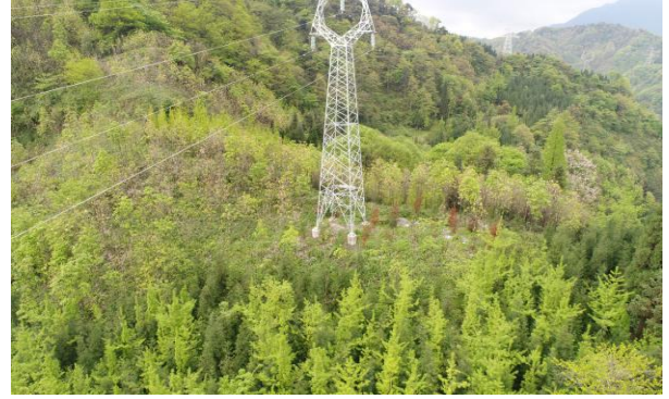
19 号塔植被恢复情况
