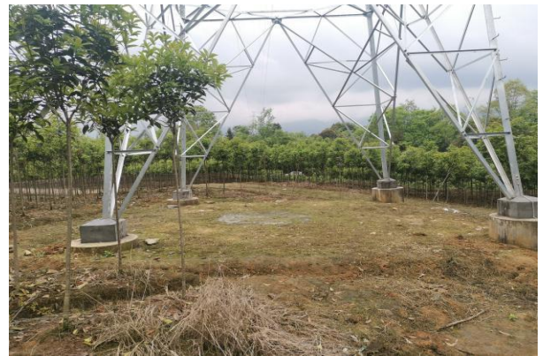
115 号塔植被恢复情况
