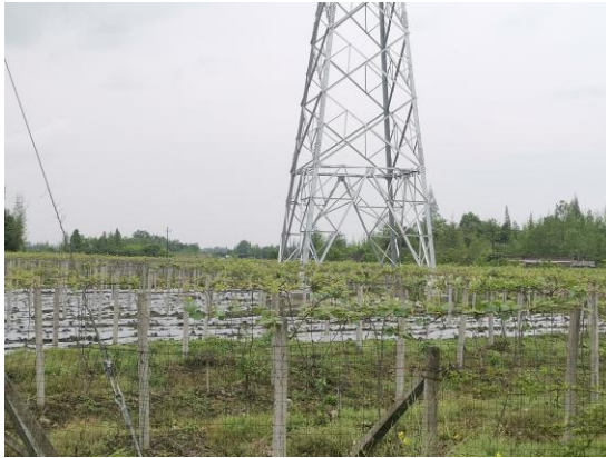
92 号塔植被恢复情况
