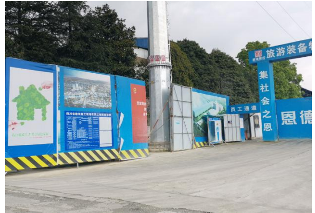
30 号杆塔硬化情况
