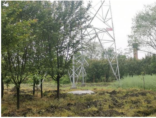
21 号塔植被恢复情况
