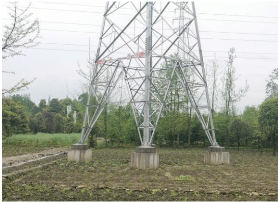
14 号塔植被恢复情况
