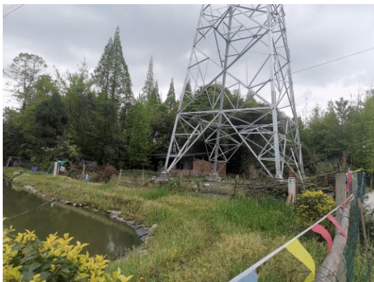
89 号塔植被恢复情况
