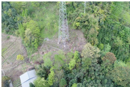
16 号塔植被恢复情况
