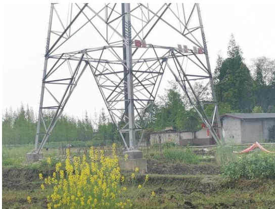
103 号塔植被恢复情况
