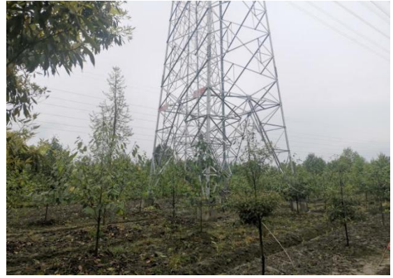
13 号塔植被恢复情况
