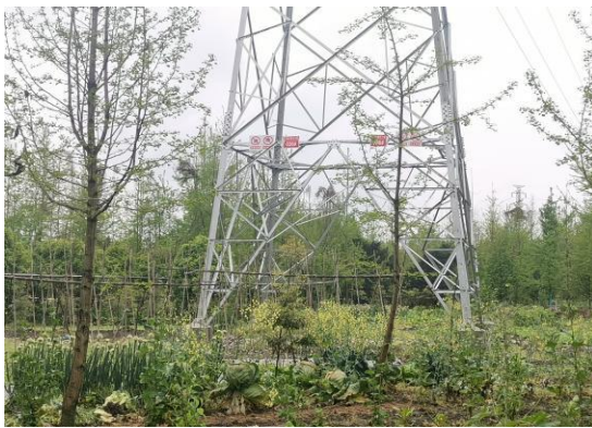
36 号塔植被恢复情况
