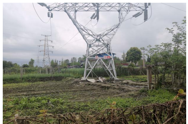
98-2 号塔植被恢复情况
