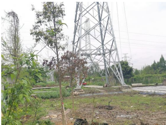
99 号塔植被恢复情况
