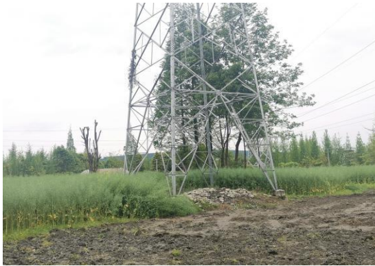
47 号塔植被恢复情况
