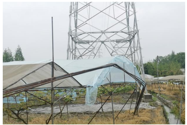
30 号塔植被恢复情况
