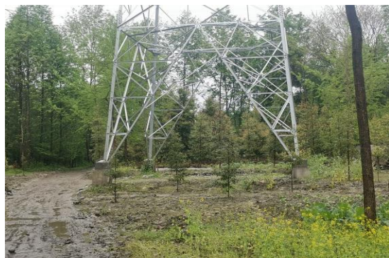
7号塔植被恢复情况
