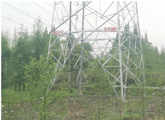
26 号塔植被恢复情况
