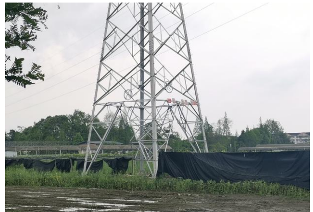
107 号塔植被恢复情况
