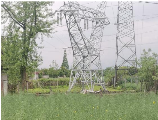
98-1 号塔植被恢复情况
