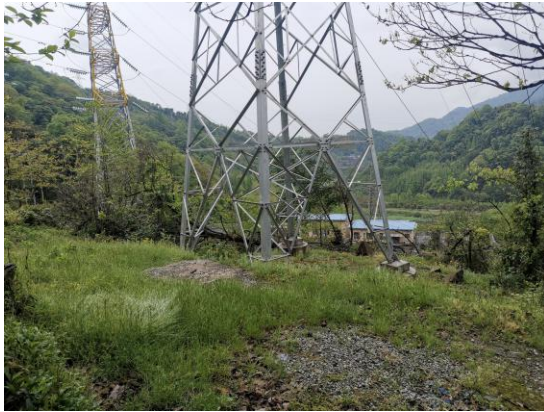
1 号塔植被恢复情况
