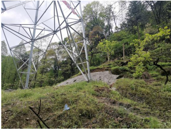
10 号塔植被恢复及护坡实施情况
