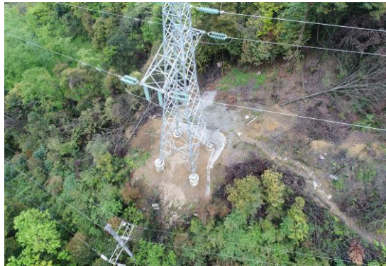
6 号塔土地整治及护坡实施情况
