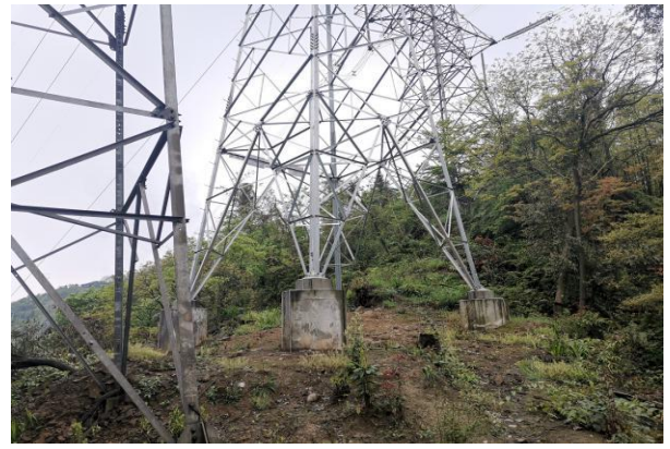
2 号塔植被恢复情况
