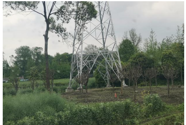
100 号塔植被恢复情况
