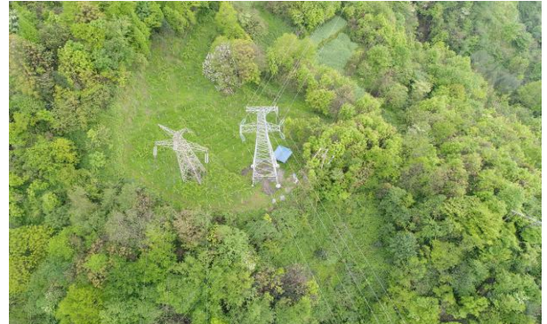
21 号塔植被恢复情况
