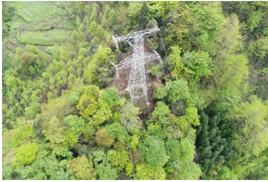
18 号塔植被恢复情况
