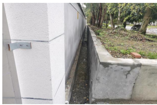
站外排水沟情况
