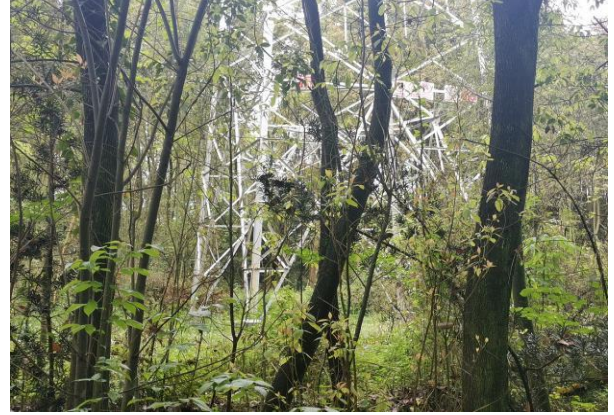
111 号塔植被恢复情况
