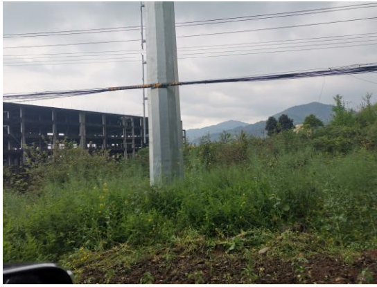
28 号塔植被恢复情况
