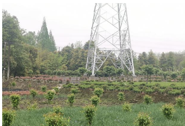
10号塔植被恢复情况
