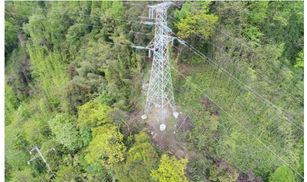
15 号塔植被恢复情况
