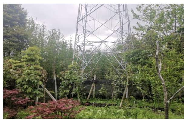
78 号塔植被恢复情况
