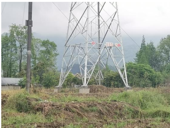
121 号塔植被恢复情况
