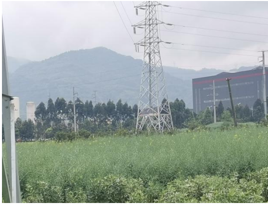
123 号塔植被恢复情况
