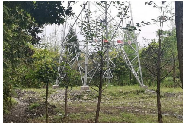
46 号塔植被恢复情况
