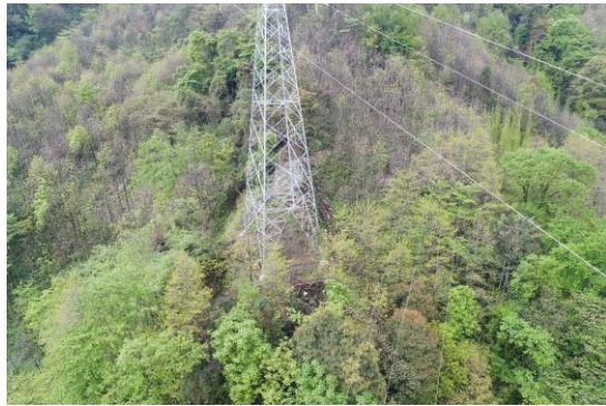
14 号塔植被恢复情况
