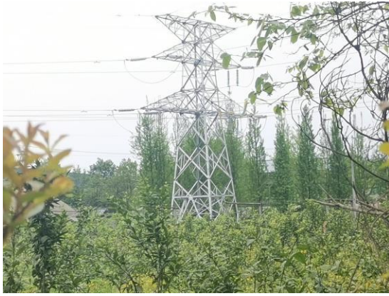
44 号塔植被恢复情况
