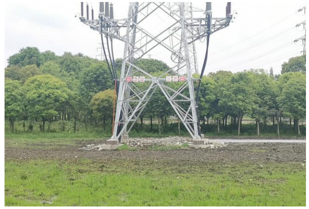
62 号塔植被恢复情况
