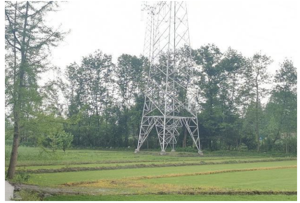
102 号塔植被恢复情况
