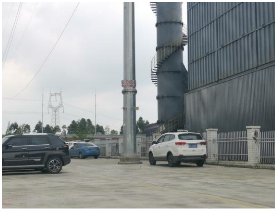
33 号杆塔硬化情况
