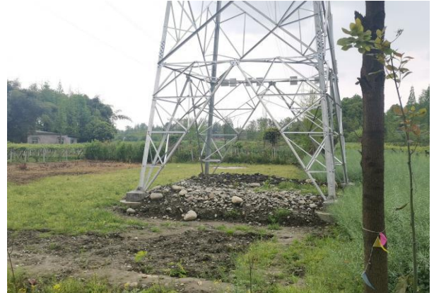
104 号塔土地整治及周边耕地恢复情况
