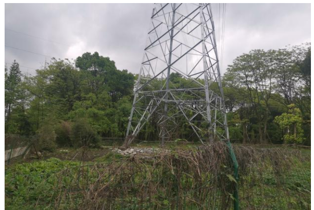
42 号塔植被恢复情况
