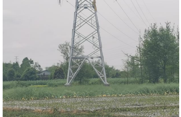
96 号塔植被恢复情况
