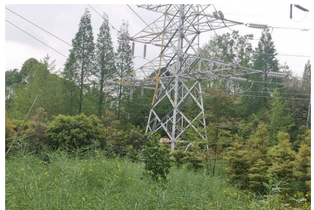
81 号塔植被恢复情况
