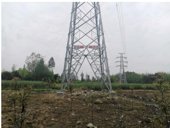
57 号塔植被恢复情况
