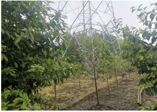
12 号塔植被恢复情况
