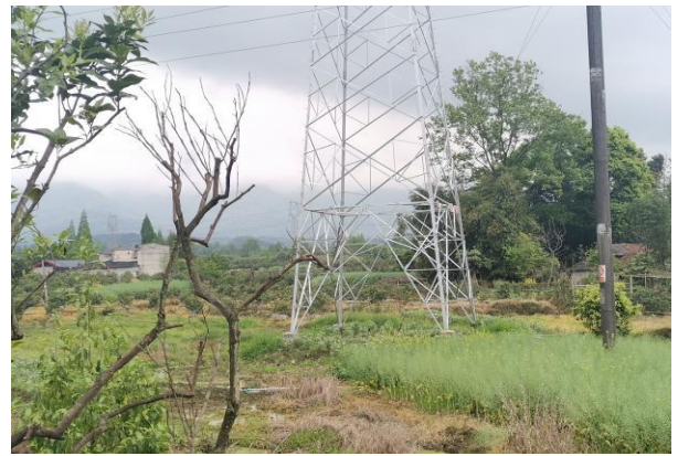
120 号塔植被恢复情况
