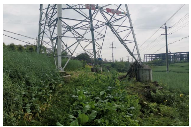
27 号塔植被恢复情况
