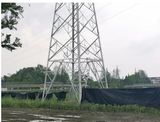
108 号塔植被恢复情况
