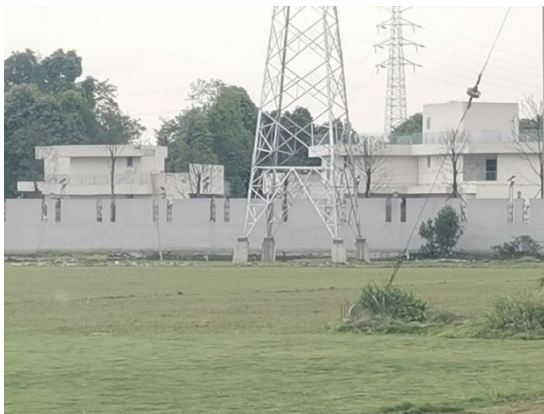
69 号塔植被恢复情况
