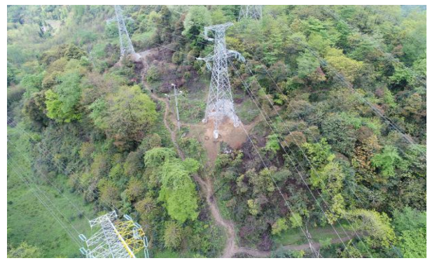
7 号塔土地整治及护坡实施情况
