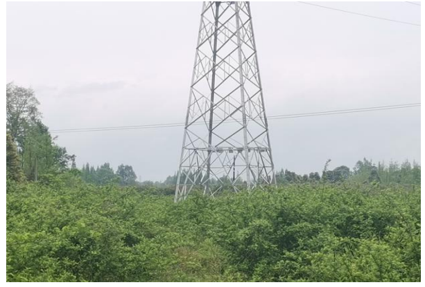
22 号塔植被恢复情况
