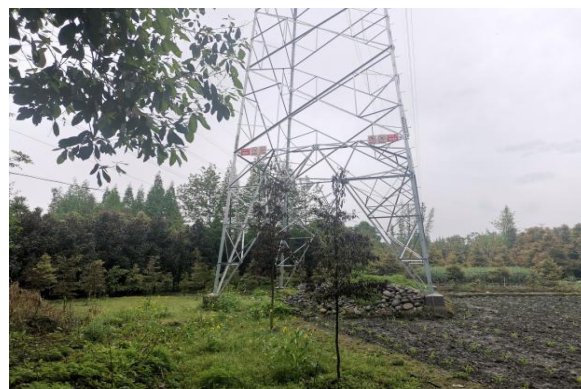
6号塔植被恢复及周边耕地情况
