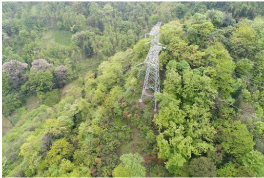
20 号塔植被恢复情况
