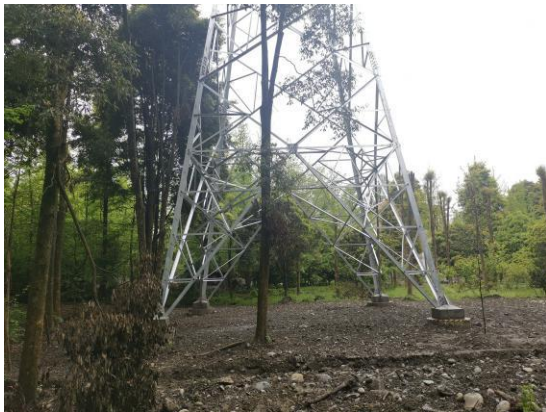
28 号塔土地恢复情况
