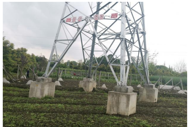
70 号塔植被恢复情况
