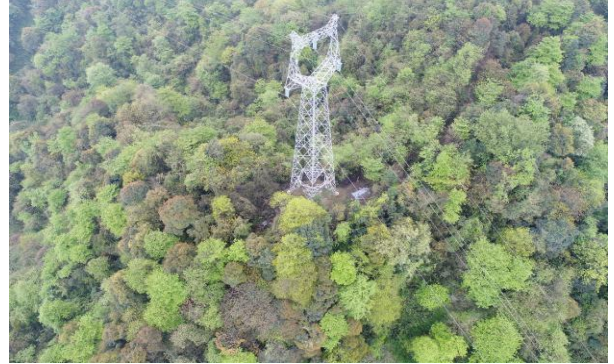
13 号塔植被恢复情况
