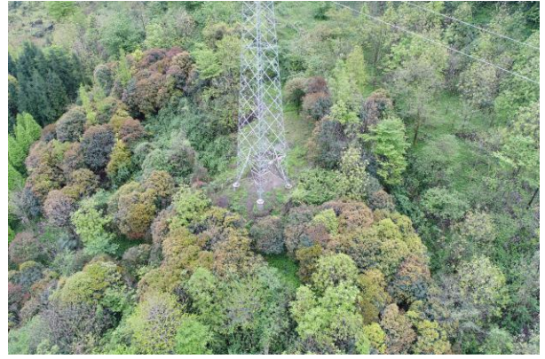
11 号塔植被恢复情况
