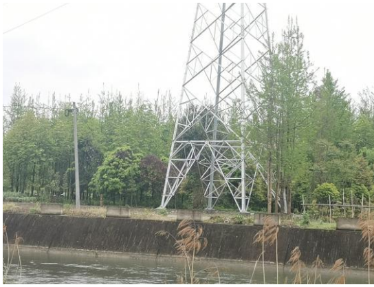
31 号塔植被恢复情况
