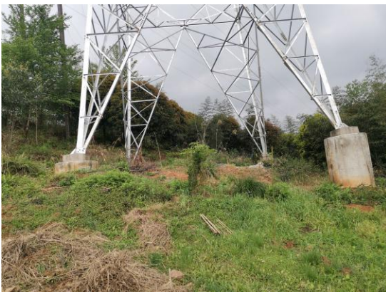
26 号塔植被恢复情况
