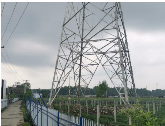
105 号塔植被恢复情况
