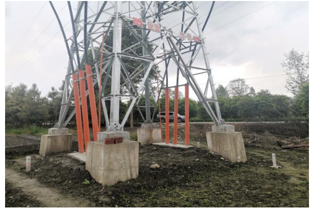
72 号塔土地恢复情况
