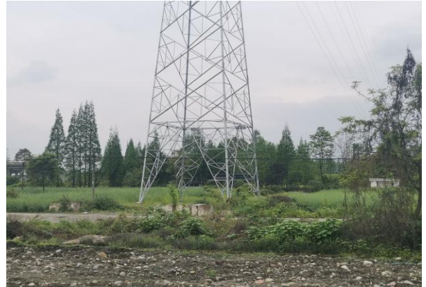
53 号塔植被恢复情况
