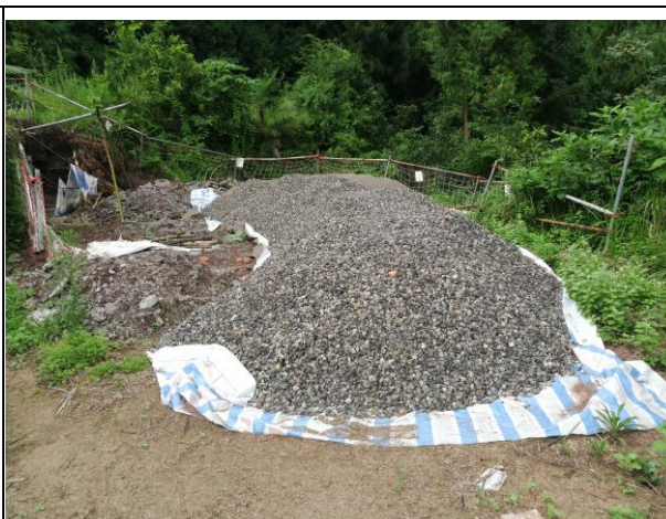
观东 II 线 BN6 塔临时苫盖
