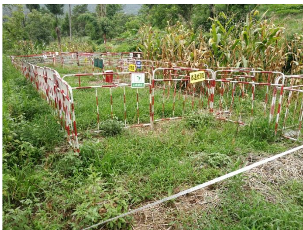
观东 II 线 BN3 施工围挡
