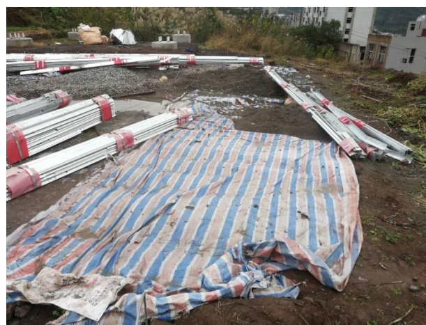
观东 I 线 AN1 塔临时苫盖
