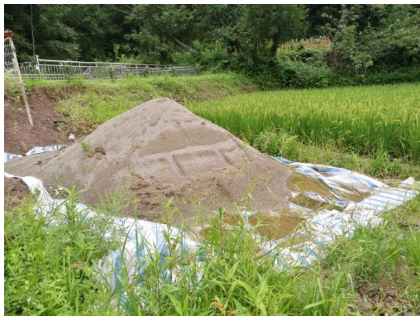
观东 II 线 BN21 塔临时苫盖
