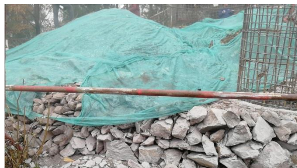
观东 I 线 AN4 塔临时苫盖
