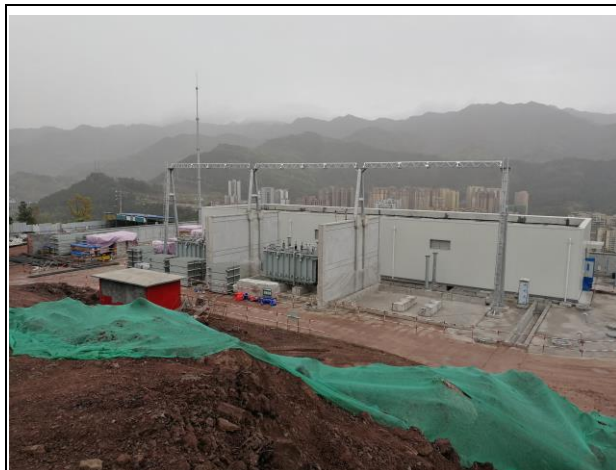
变电站站区临时苫盖
