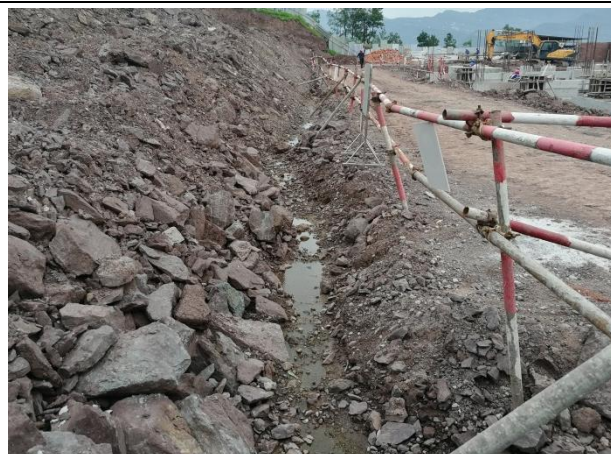
变电站站区临时排水沟
