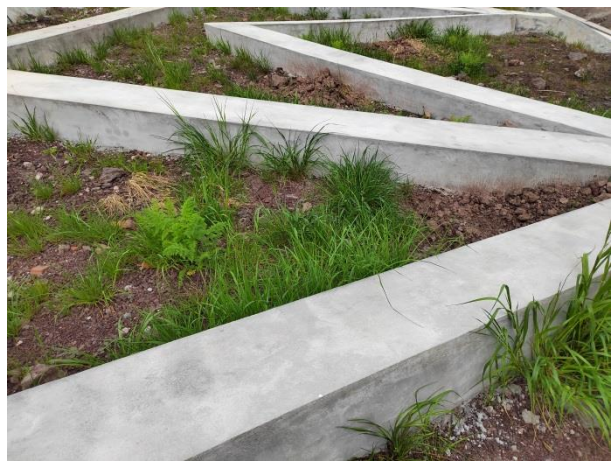
边坡治理区绿化
