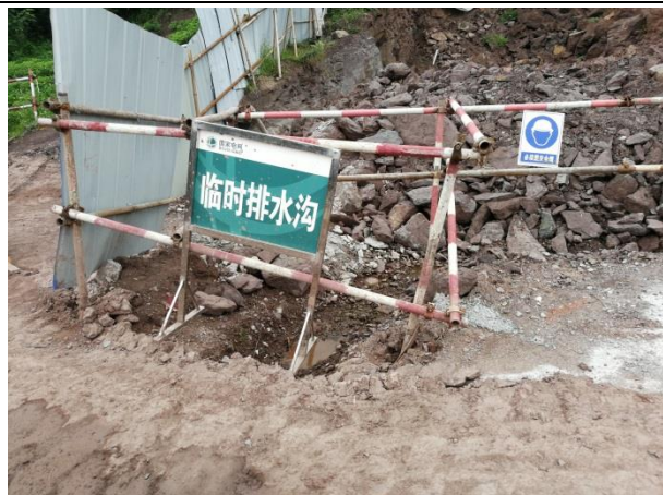
变电站站区临时排水沟
