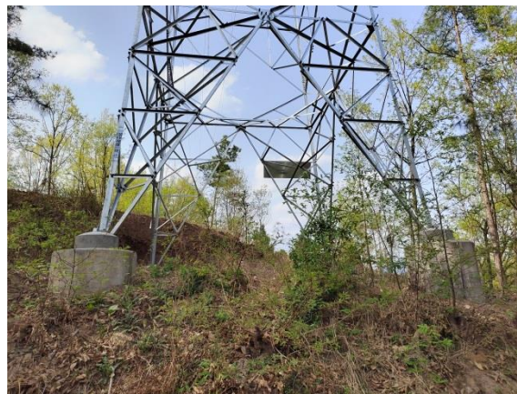
观东 I 线 AN18 塔基区绿化措施
