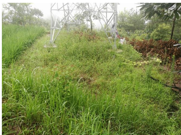
观东 II 线 BN18 塔基区绿化措施
