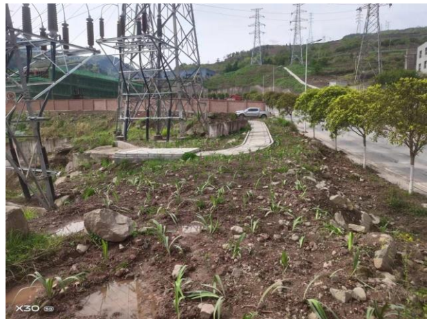
电缆施工区绿化
