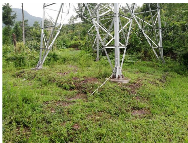
观东 II 线 BN3 塔基区绿化措施
