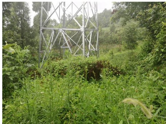
观东 I 线 AN19 塔基区绿化措施
