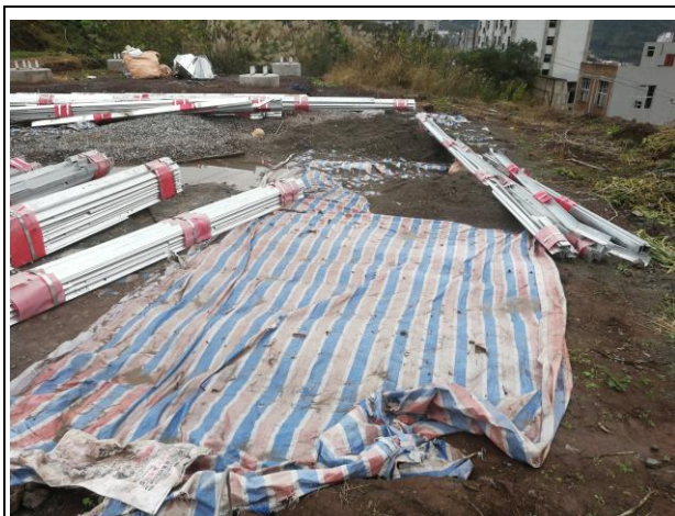
观东 I 线 AN1 塔临时苫盖
