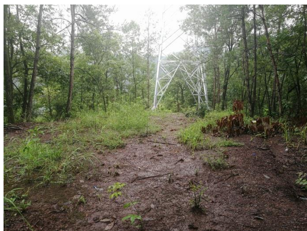
观东 II 线 BN11 旁牵张场绿化措施
