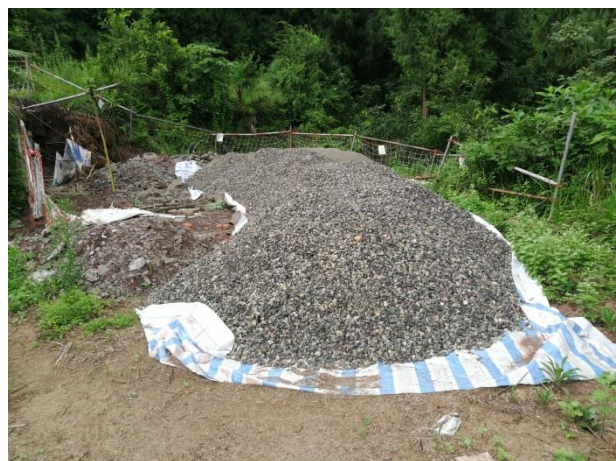
观东 II 线 BN6 塔临时苫盖
