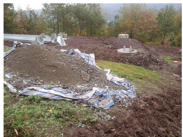
观东 II 线 BN19 塔临时苫盖
