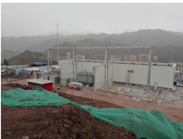
变电站站区临时苫盖
