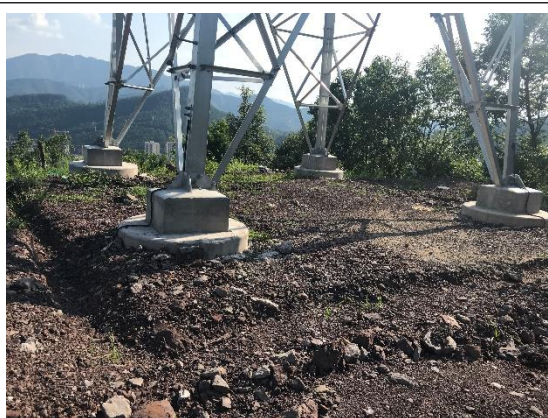
建设中典型照片
