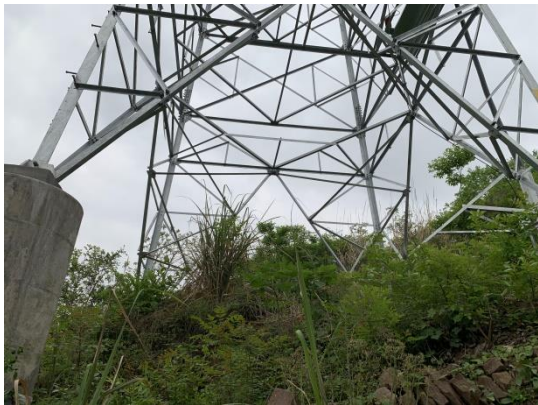
34 号塔植被恢复情况
