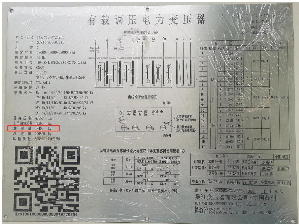
图 4-10 主变压器出厂铭牌
