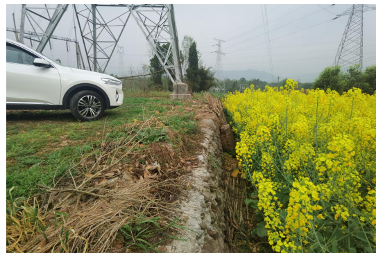
高川-桑枣 1#塔基
