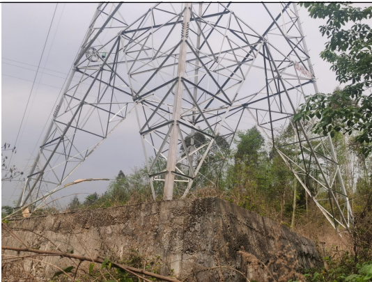
高川-桑枣 13#塔基
