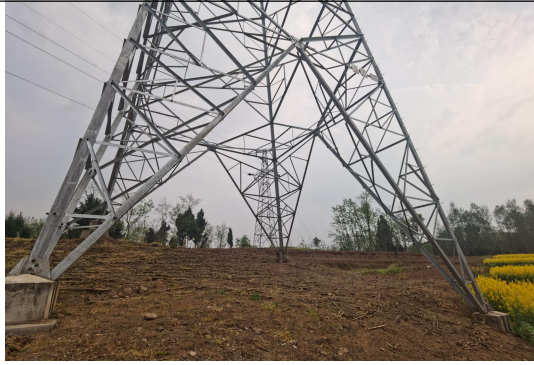
高川-桑枣 2#塔基
