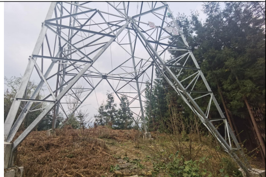
高川-曲山 43#塔基
