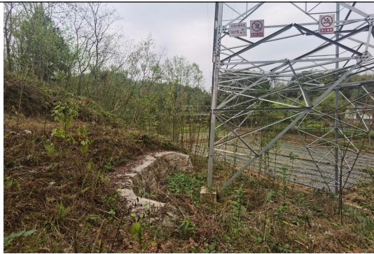
高川-桑枣 7#塔基
