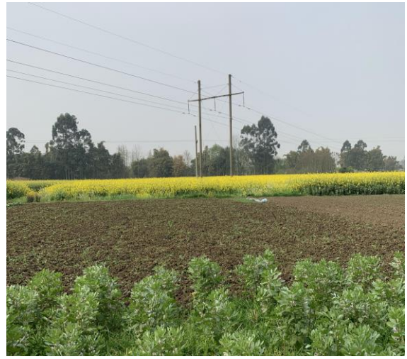
(2) 线路沿线地貌、植被
