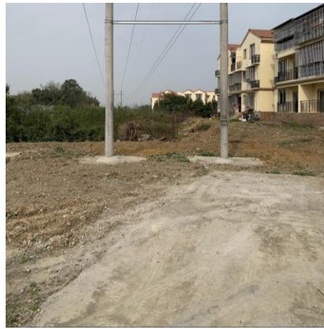
(6) 线路沿线地貌
