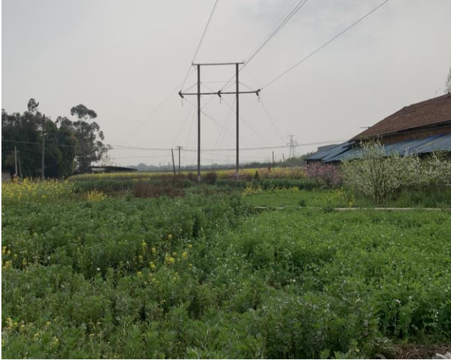
(1) 线路沿线地貌、植被
