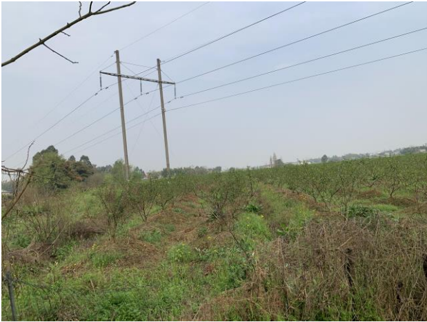
(3) 线路沿线地貌、植被
